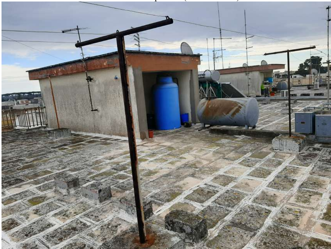
Foto 11 – Vista piano 4 (lastrico solare)
