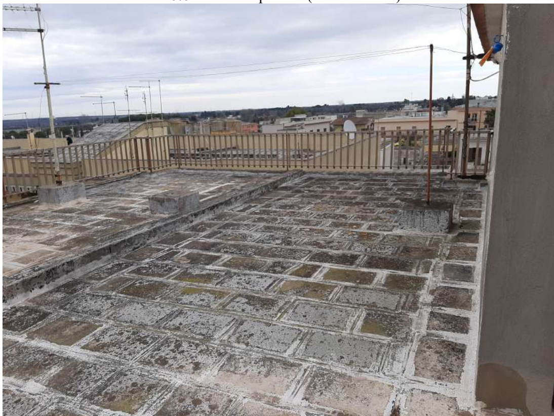
Foto 12 – Vista piano 4 (lastrico solare)
