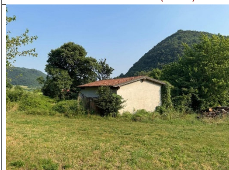
Foto 3. VISTA PANORAMICA (da Nord/Ovest)
