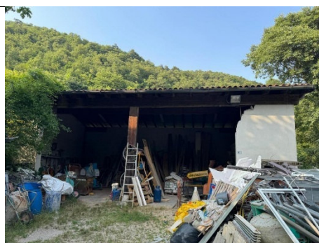
Foto 2. VISTA (da Sud)
