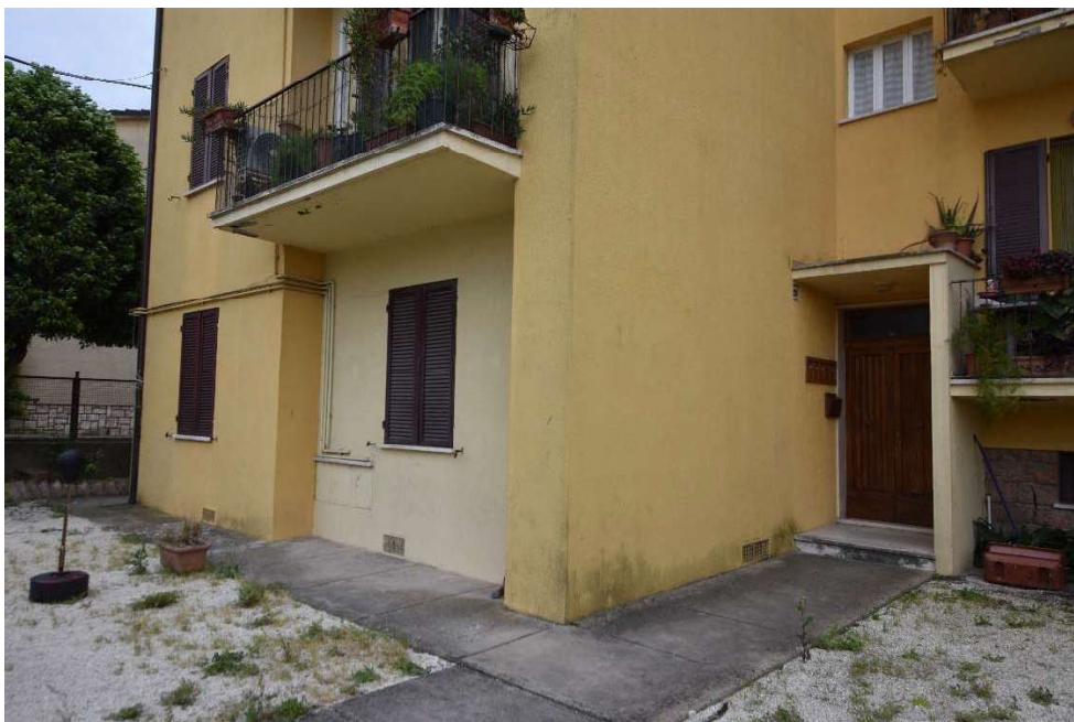
FRONTE STRADA PUBBLICA CON ACCESSO DALLA CORTE
