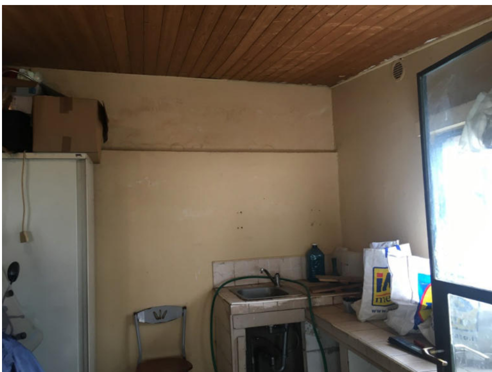
FOTO 12: CAMBIAGO, VIA DELLA DEPUBBLICA 13, deposito
