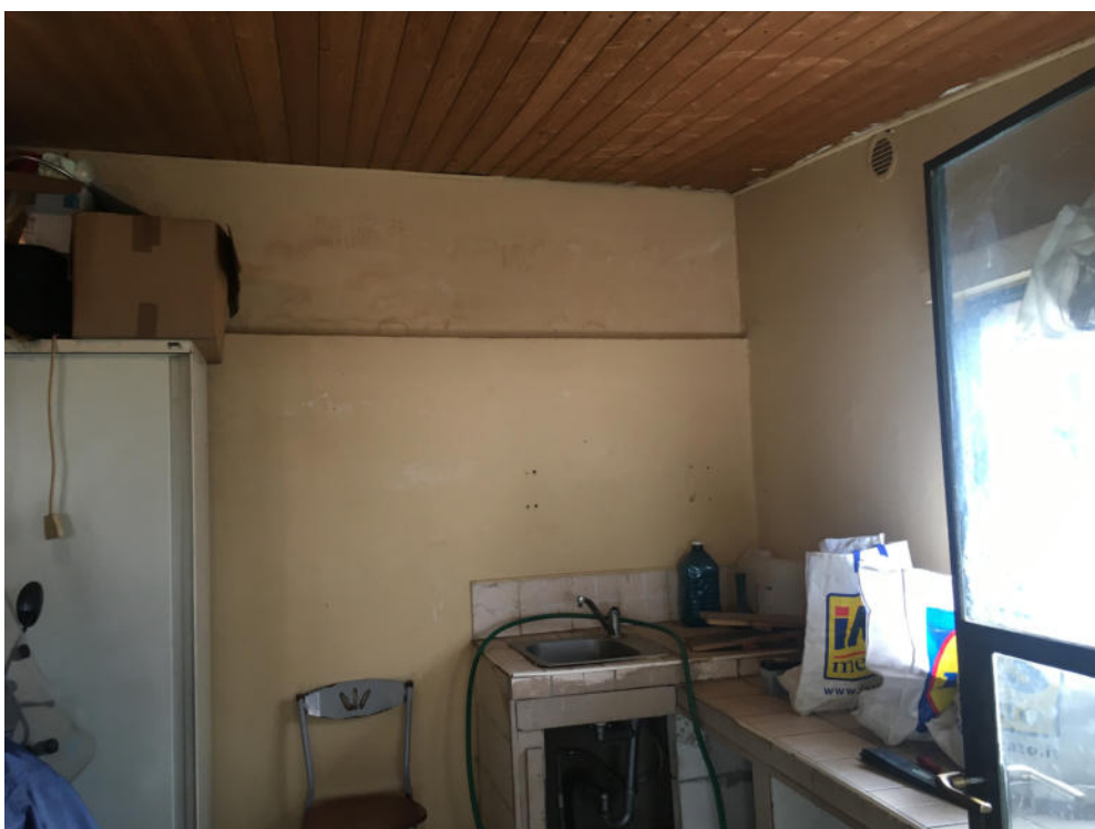
FOTO 12: CAMBIAGO, VIA DELLA REPUBBLICA 13, deposito
