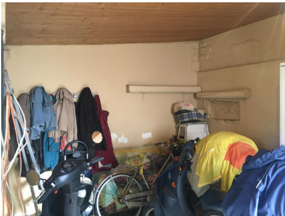
FOTO 11: CAMBIAGO, VIA DELLA DEPUBBLICA 13, deposito
