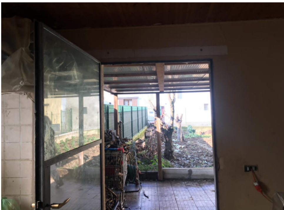
FOTO 13: CAMBIAGO, VIA DELLA DEPUBBLICA 13, deposito-vista sull'orto di pertinenza
