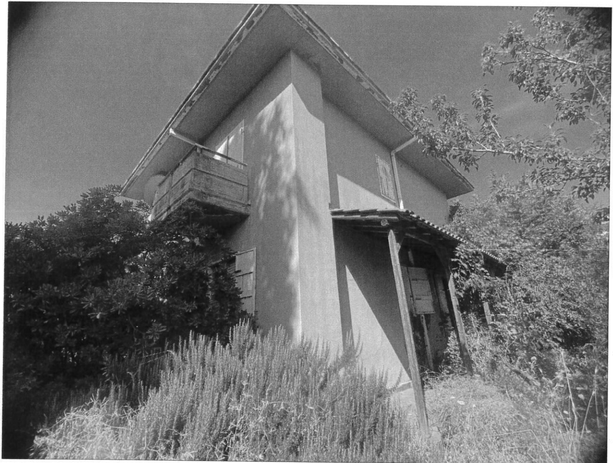
Foto Prospetti Esterni
