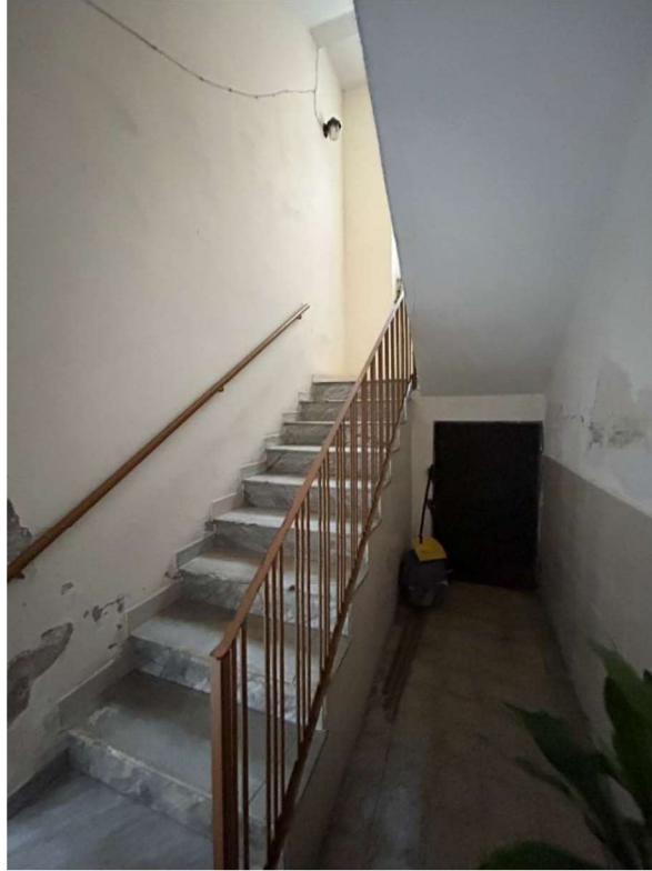
Foto n. 5 – Vano scala del fabbricato
