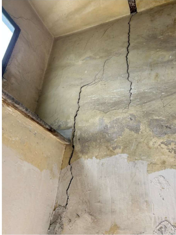
Foto n. 67 – Vano scala di accesso al quarto piano
