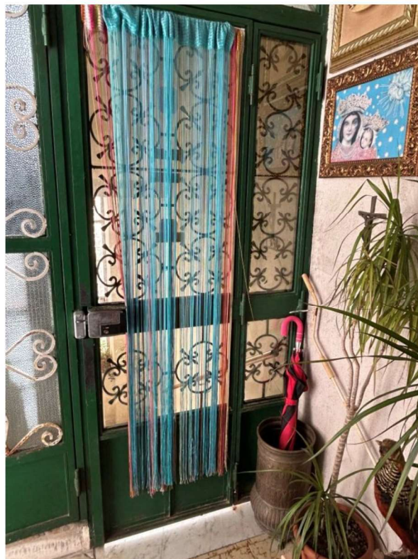
Foto n. 8 – Ballatoio di accesso all'immobile verso il vano scala
