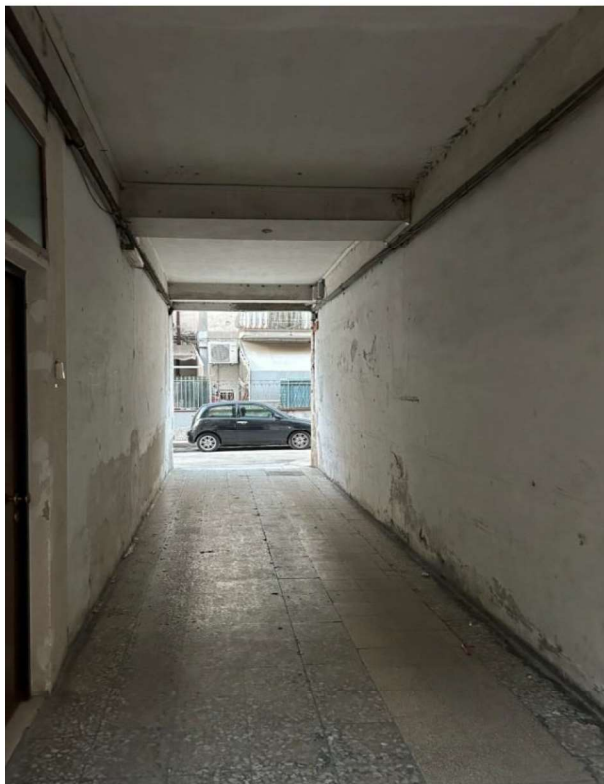
Foto n. 4 – Androne del fabbricato
