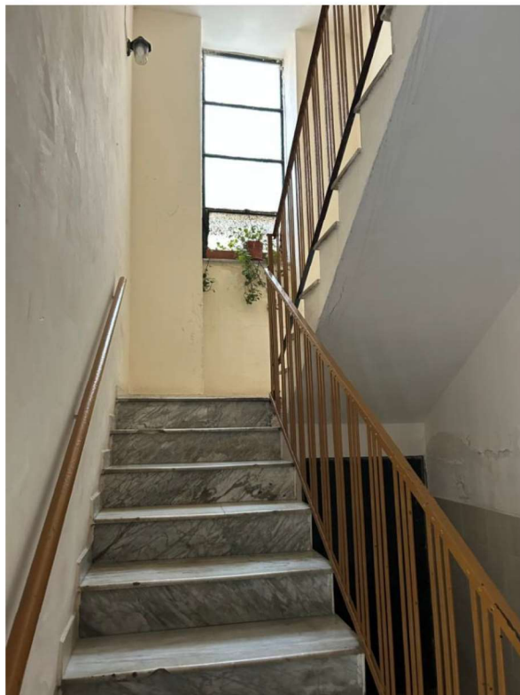
Foto n. 6 – Vano scala del fabbricato
