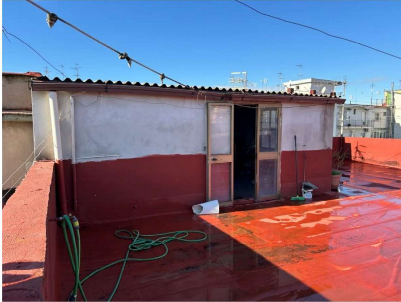
Foto n. 91 – Lastrico verso il locale deposito
