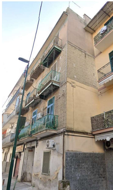
Foto n. 2 – Fabbricato in cui è ubicato l'immobile pignorato
