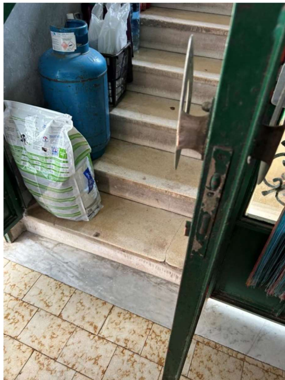
Foto n. 64 – Ballatoio – ingresso al vano scala di accesso al quarto piano
