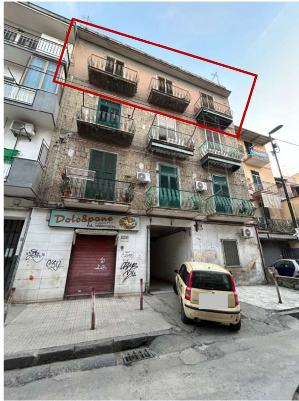
Foto n. 1 – Fabbricato in cui è ubicato l'immobile pignorato
