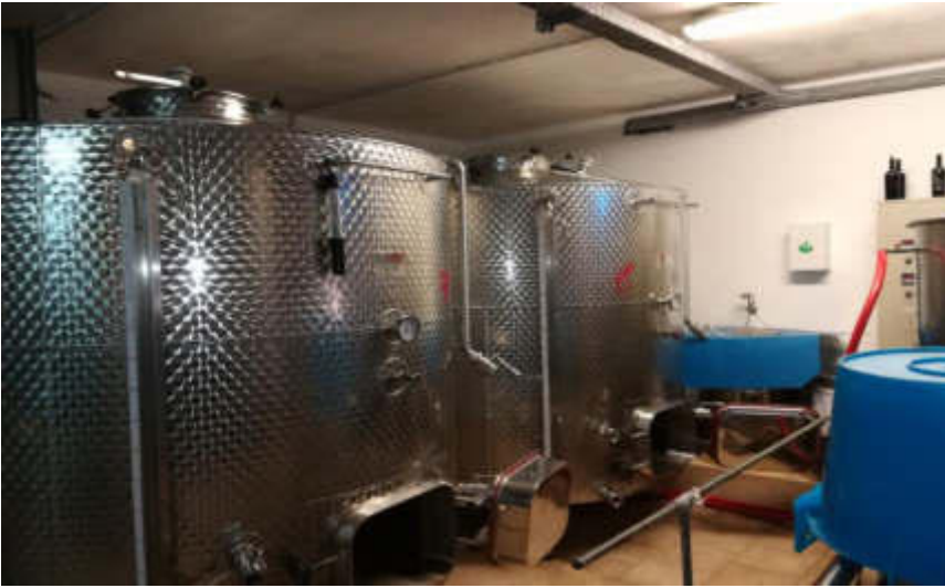
Vista 4 ambiente magazzino
