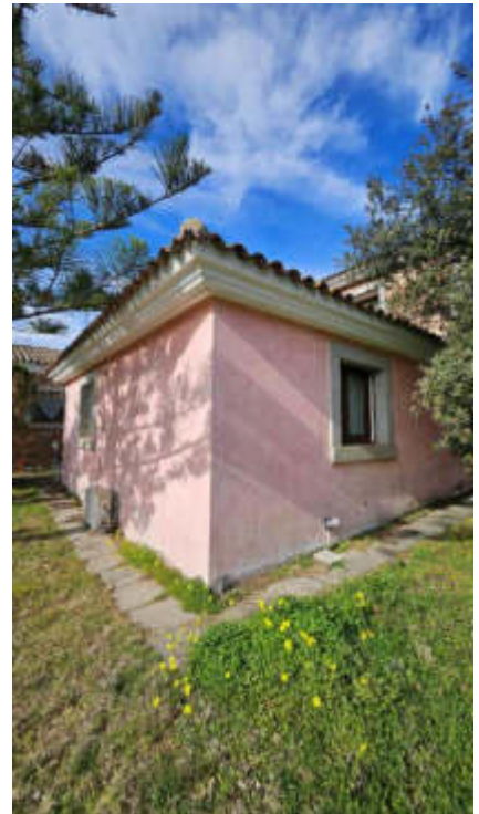
Vista prospetto su Via Cesare Balbo
