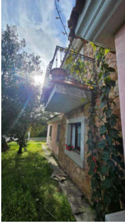
Vista prospetto su Via Cesare Balbo
