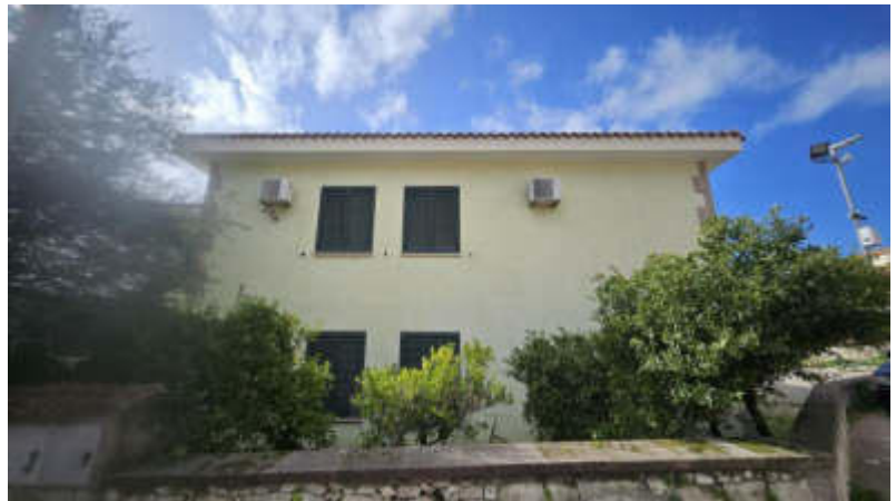
Prospetto laterale vista da via La Muddizza
