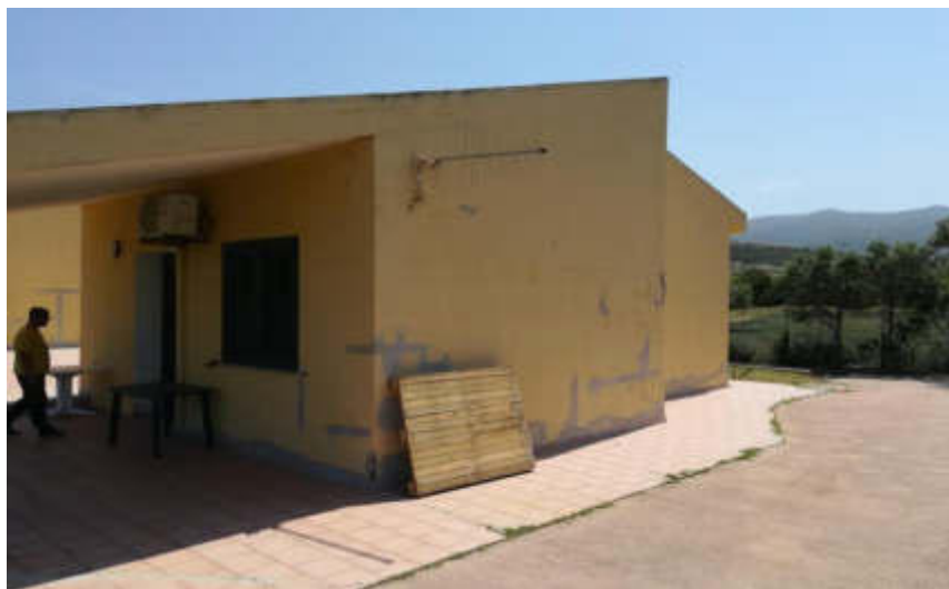
2) Vista prospetto Sud
