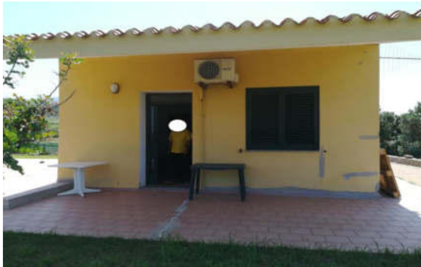
1) Vista prospetto Ovest
