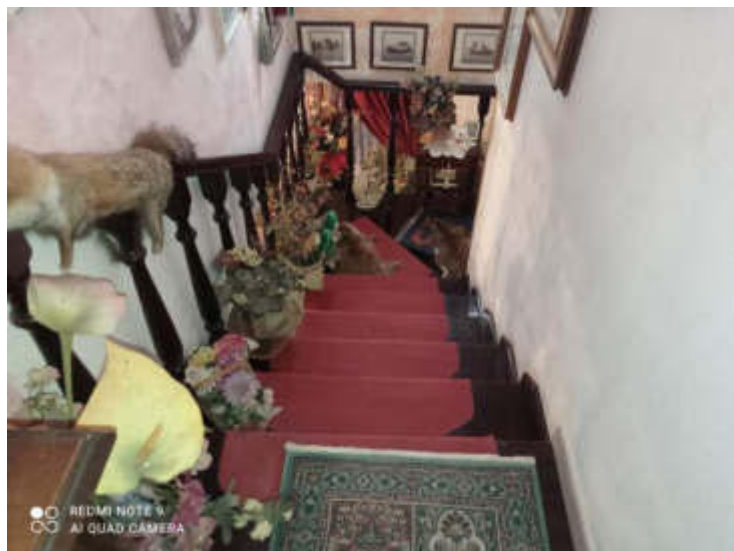
Scale di collegamento piano primo -piano secondo
