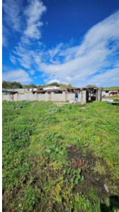
Vista mappale 564 e struttura precaria
