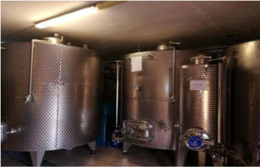
Vista 3 ambiente magazzino
