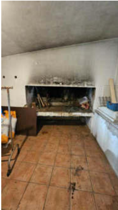
Sgombero (ingresso da tettoia )
