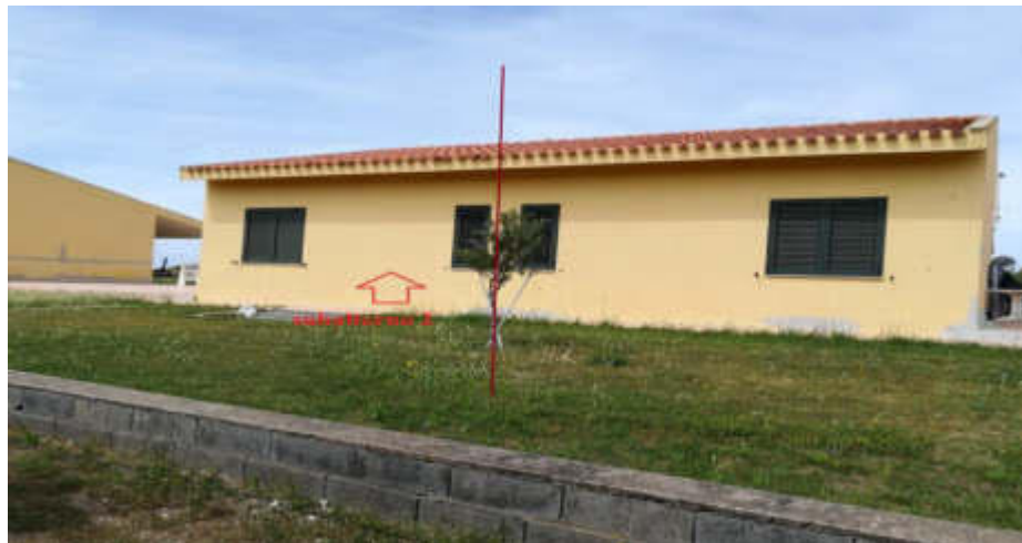
2) Vista prospetto est
