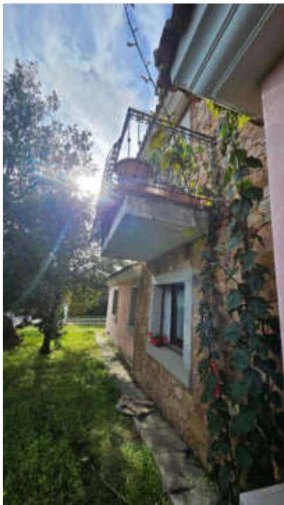
Vista prospetto su cortile
