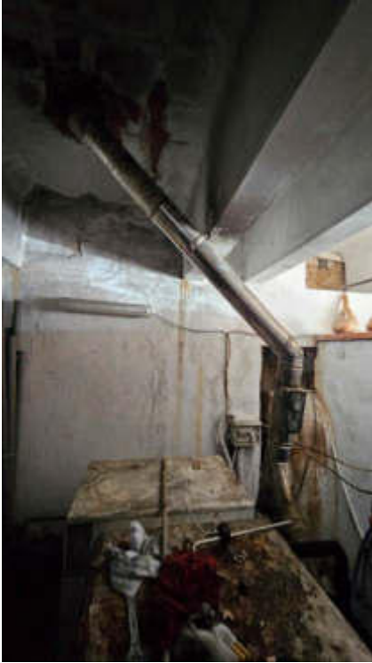
Tettoia alloggiamento impianti
