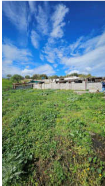
Vista mappale 564 e struttura precaria
