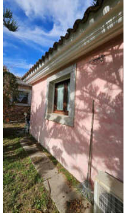
Vista prospetto su Via Cesare Balbo
