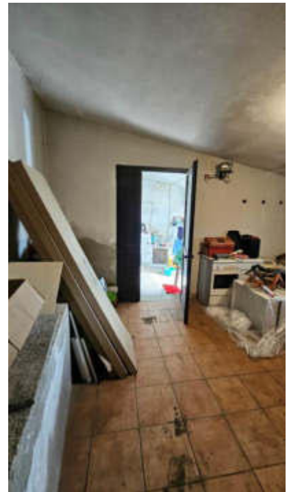
Sgombero (ingresso da tettoia )
