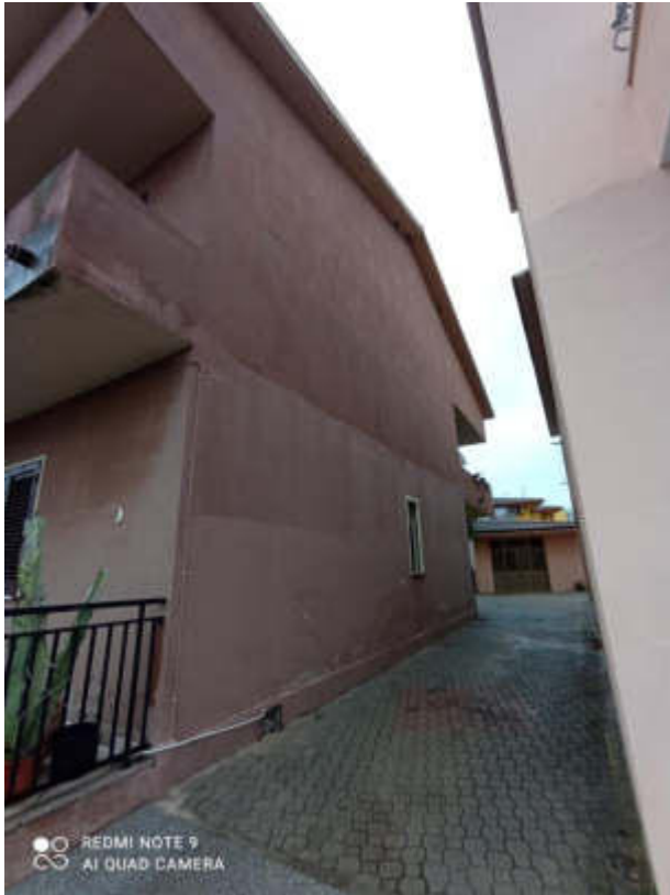
Prospetto su Viottolo Interno
