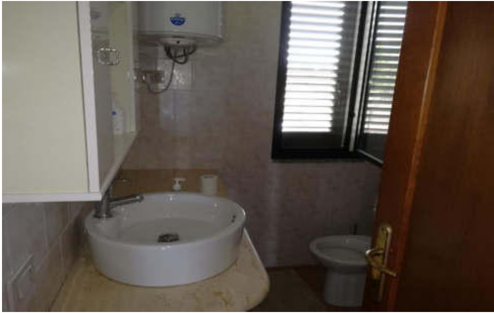
Vista ambiente wc
