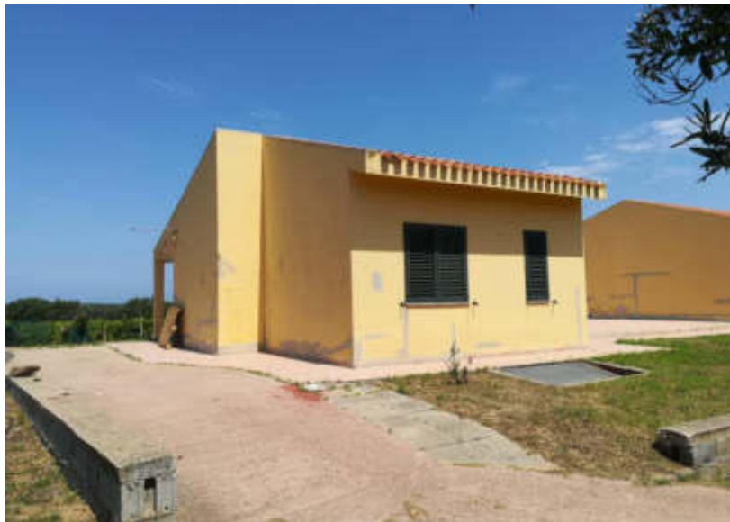
4) Vista prospetto Est
