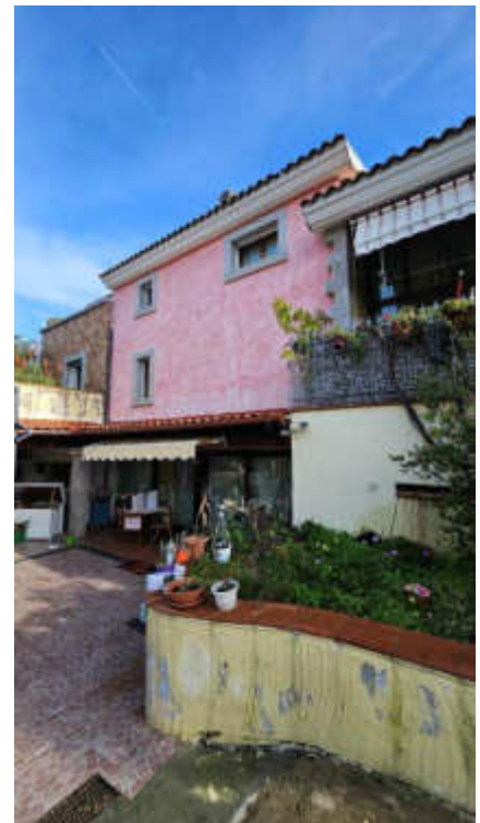
Vista prospetto su cortile
