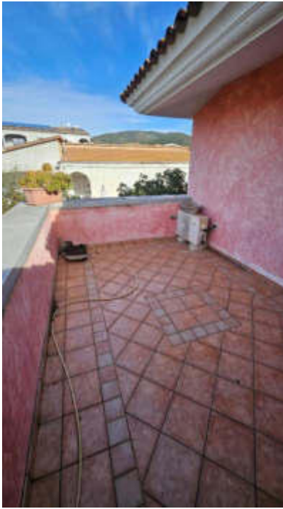
Terrazza accesso da Ambiente soppalco
