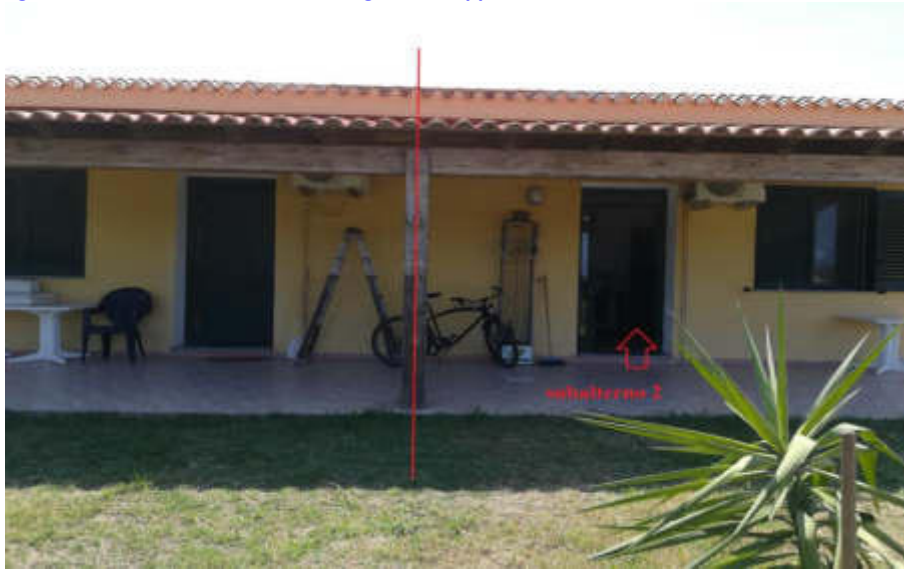
1) Vista prospetto Ovest
