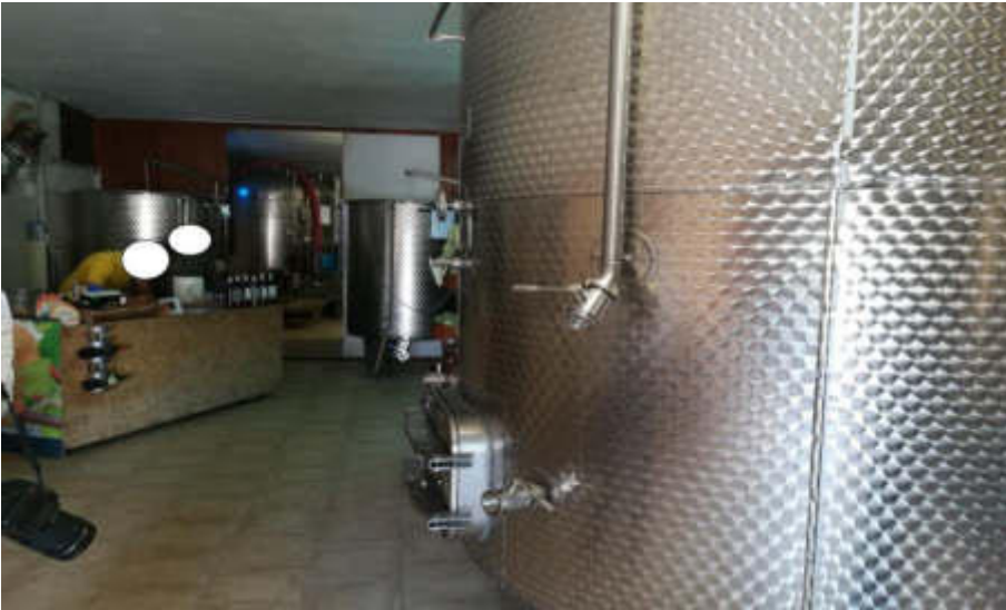
Vista 1 ambiente magazzino
