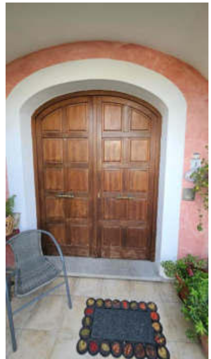
Vista prospetto ingresso
