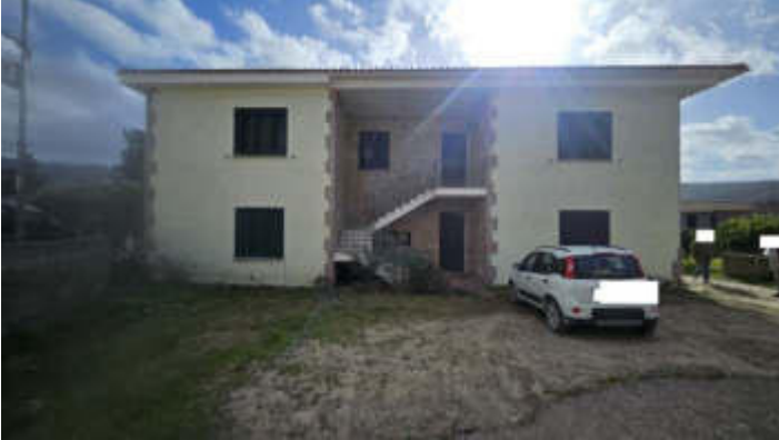
Prospetto principale Vista da Via La Muddizza
