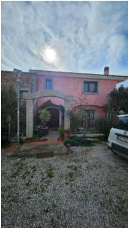
Vista prospetto ingresso
