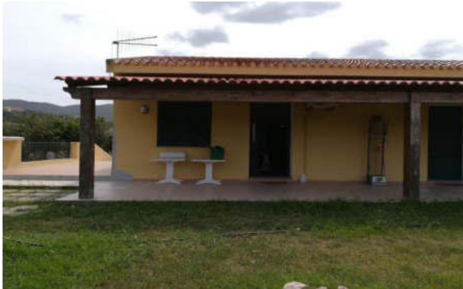
3) Vista prospetto ovest
