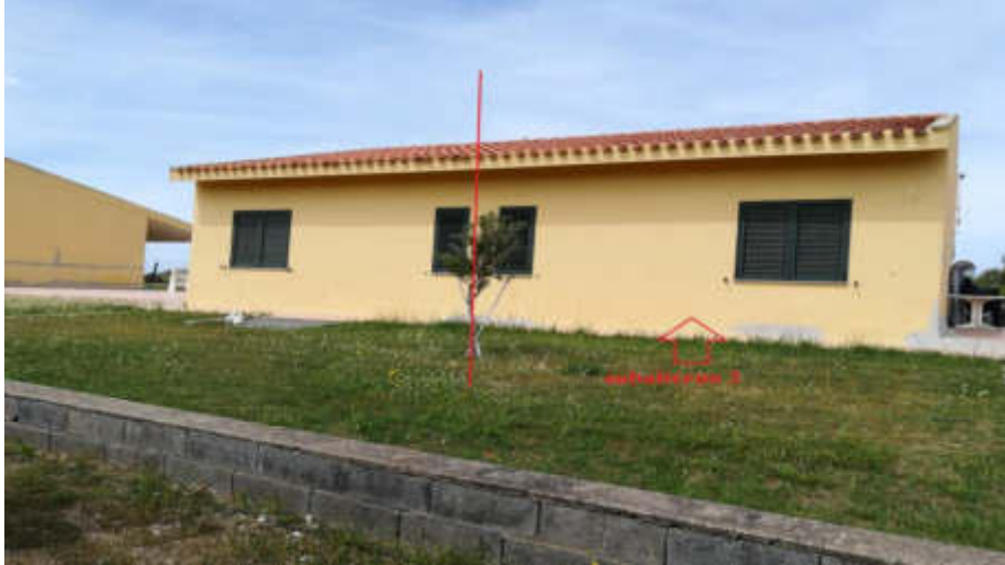
1) Vista prospetto est
