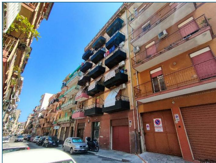
Edificio sito in via Scillato n. 60
