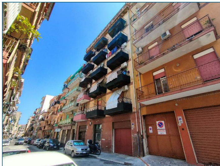
Edificio sito in via Scillato n. 60
