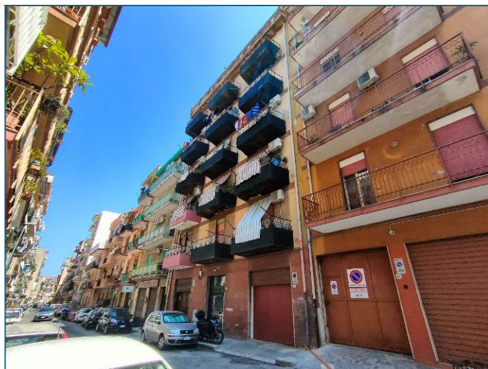
Edificio sito in via Scillato n. 60
