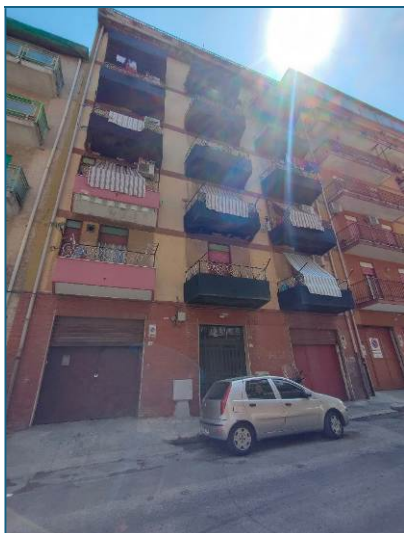
Edificio sito in via Scillato n. 60
