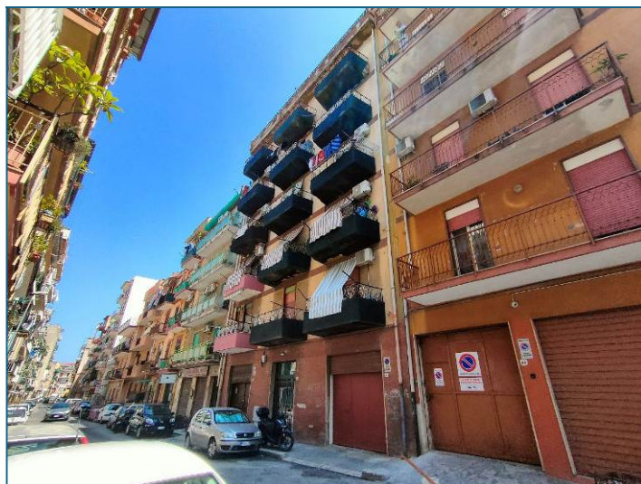
Edificio sito in via Scillato n. 60
