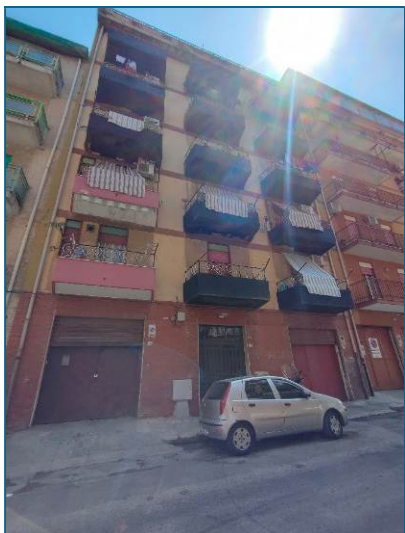
Edificio sito in via Scillato n. 60
