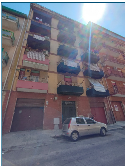
Edificio sito in via Scillato n. 60
