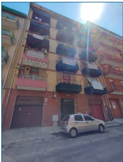
Edificio sito in via Scillato n. 60
