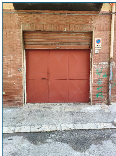
Portone metallico di accesso all'immobile
