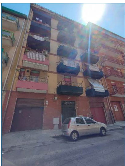
Edificio sito in via Scillato n. 60
