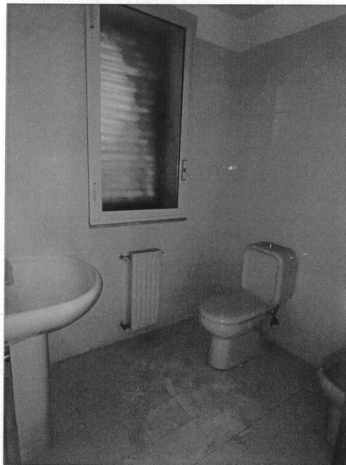
Bagno al piano terra
