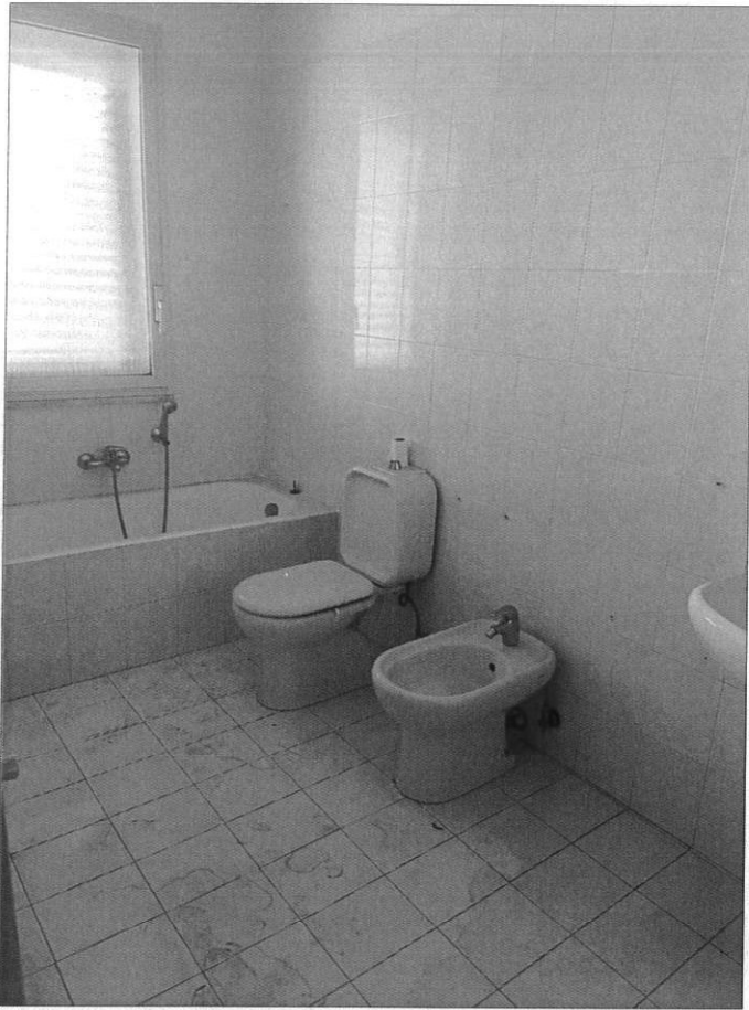
Bagno piano primo
