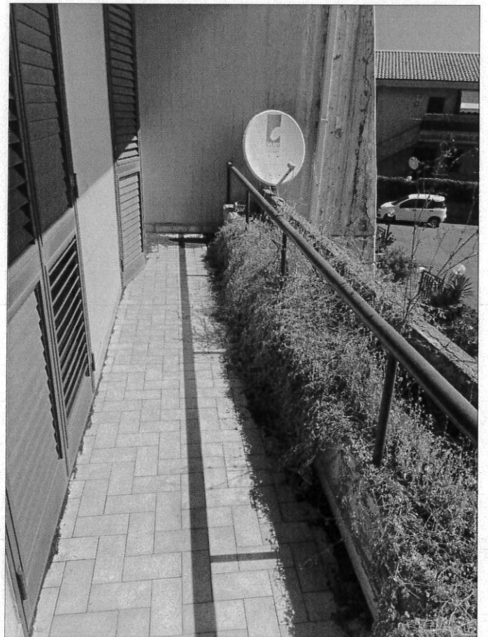
Balcone al piano primo
