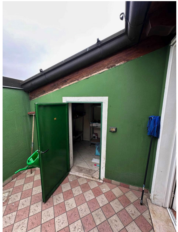
Foto 33- Ripostiglio in terrazza
