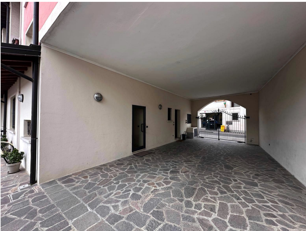
Foto 6 - Passaggio di ingresso
