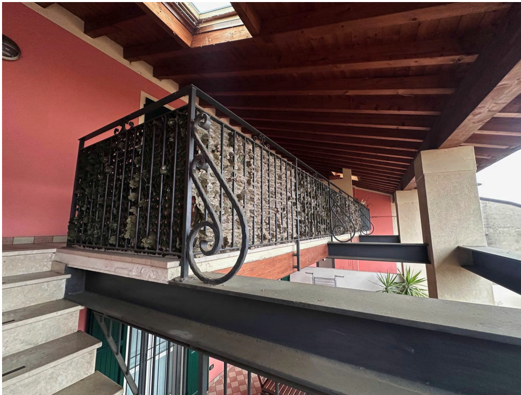
Foto 14 - Vista da scala comune
