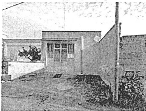
Prospetto su via S. D'Acquisto, 21
