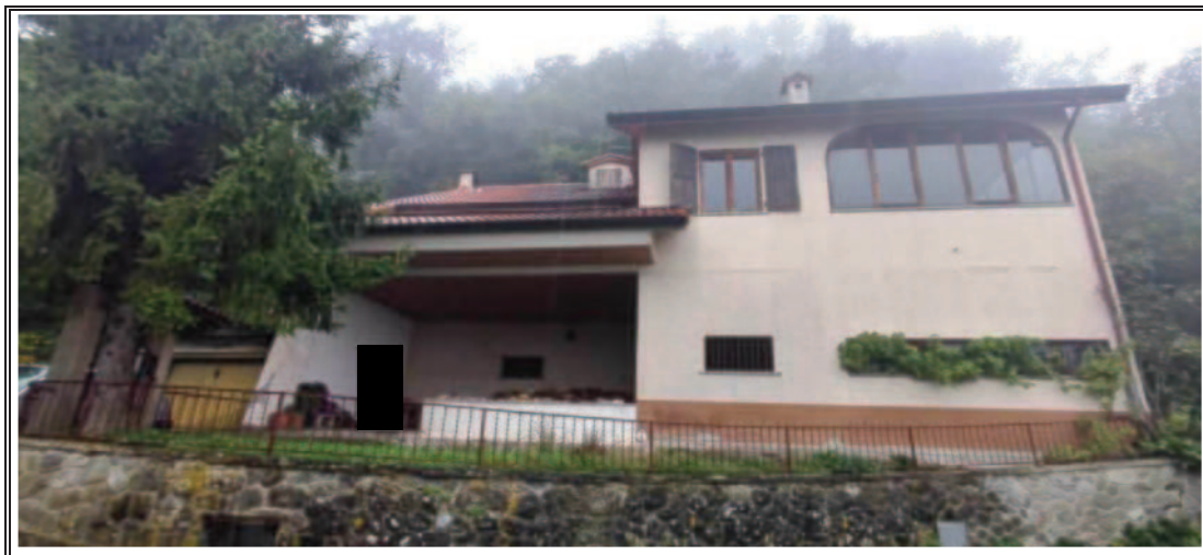
Foto n. 1 – Vista del fabbricato facciata lato EST
