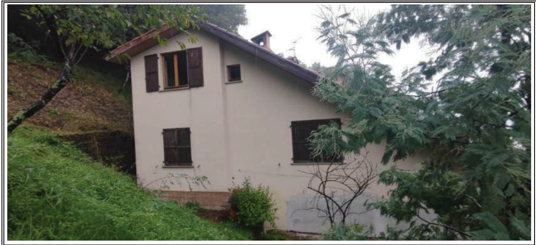
Foto n. 4 – Vista del fabbricato facciata lato SUD
