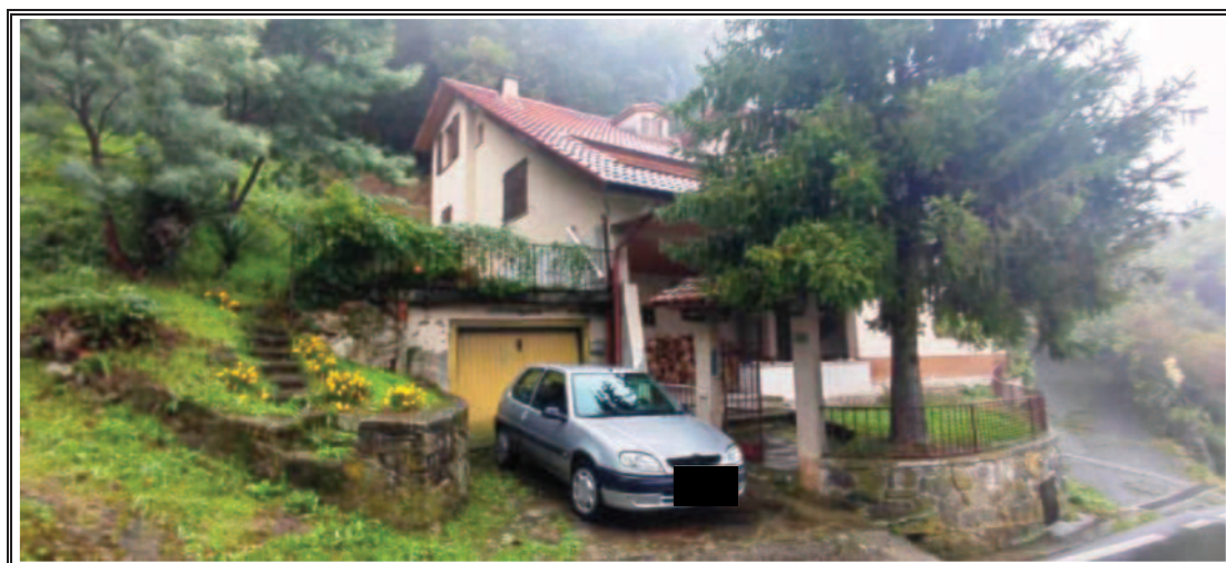
Foto n. 2 – Vista del fabbricato angolo SUD/EST
