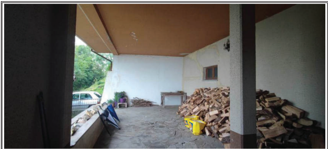
Foto n. 5 – Portico di ingresso al piano seminterrato
