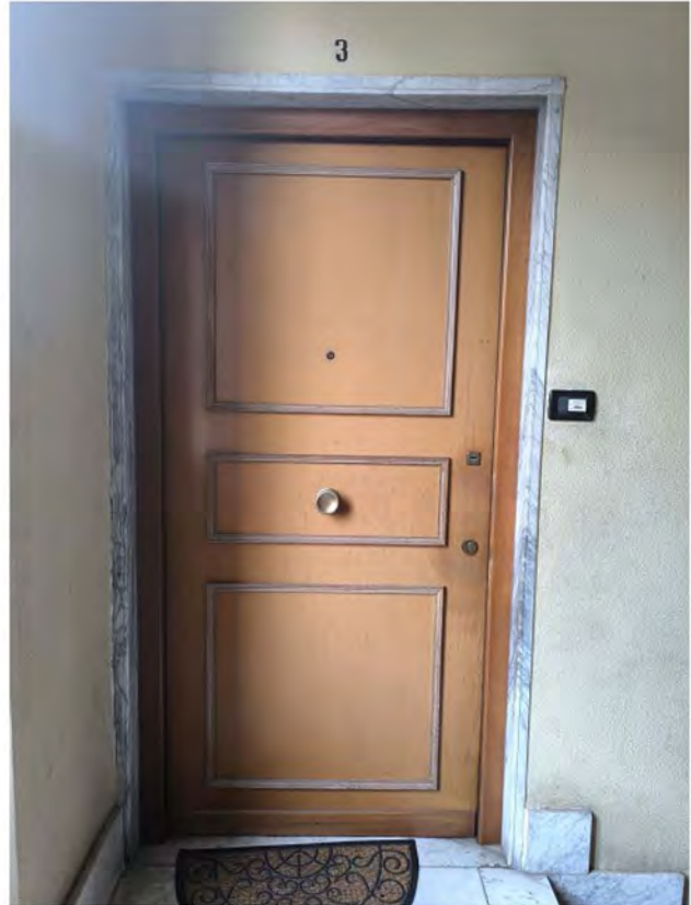
Foto 11: piano primo, int. 3 porta di ingresso
