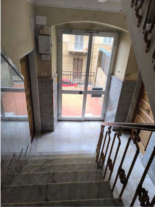
Foto 10: atrio e vano scala condominiale
