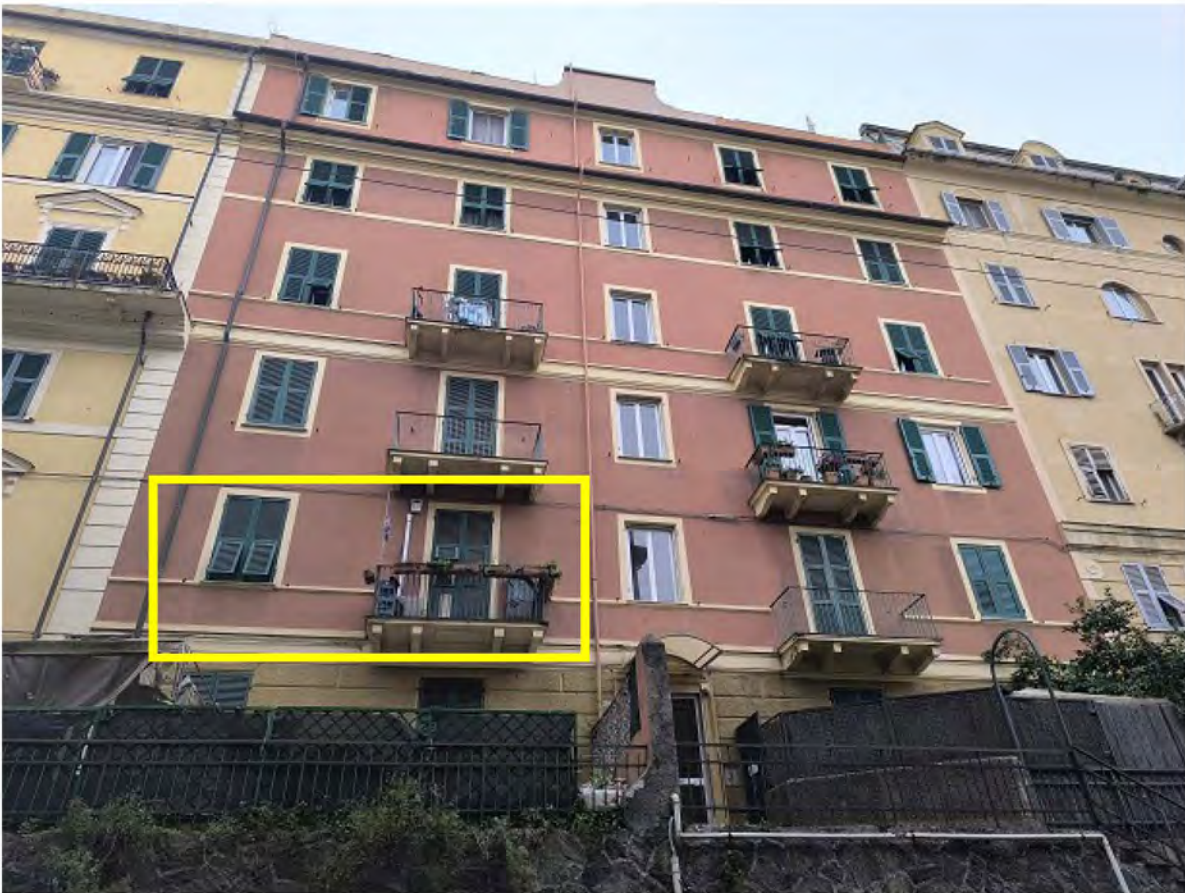
Foto 4: civico n. 17, fronte nord-est con riquadro di evidenza sulle finestre dell'int. n. 3 a primo piano
