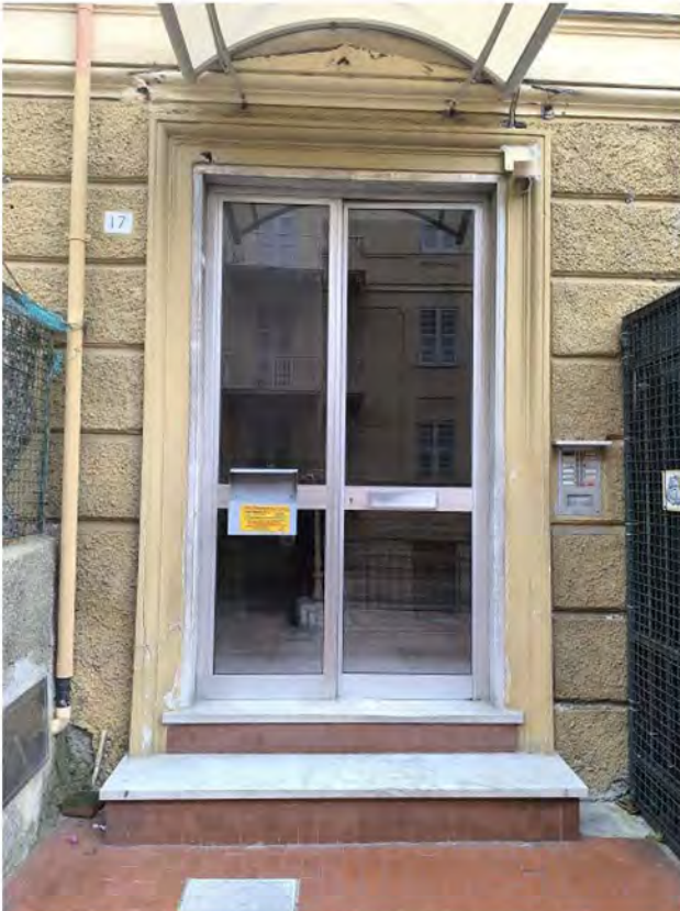
Foto 8: portone di ingresso del civico n. 17
