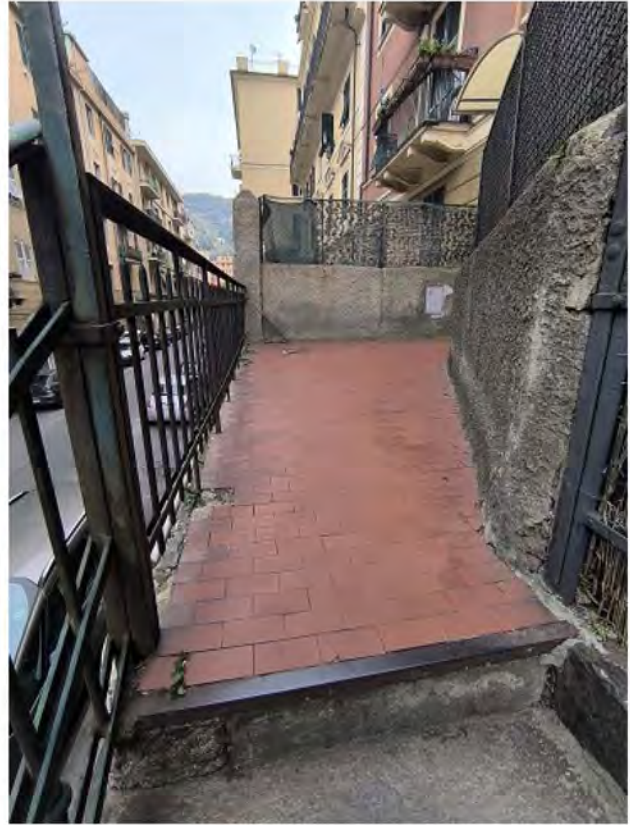
Foto 7: pianerottolo che conduce al portone di ingresso del civico n. 17
