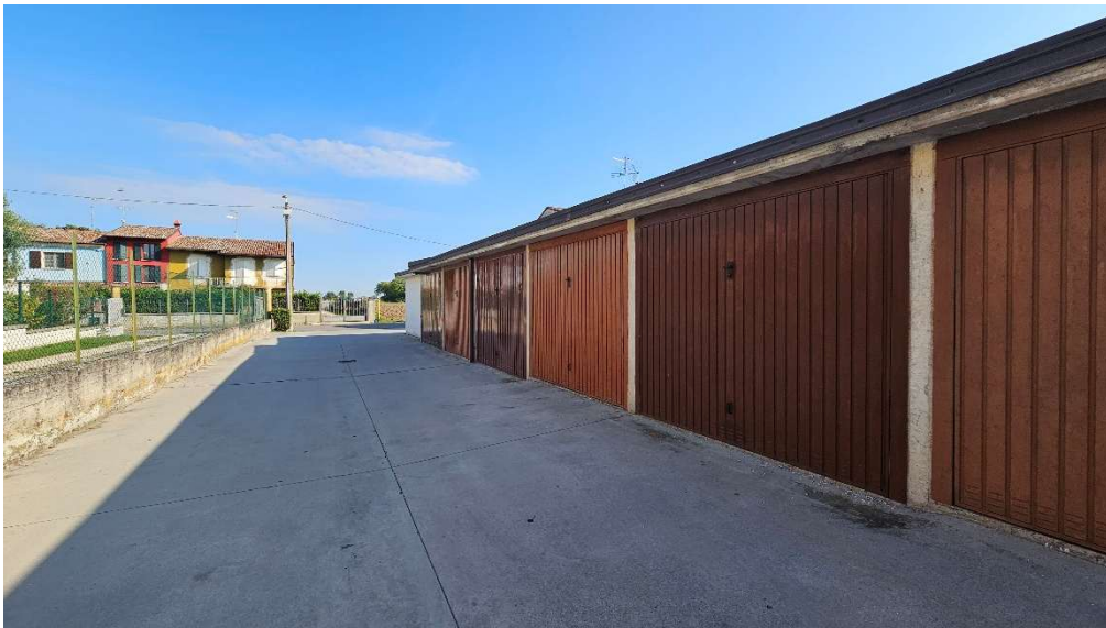
Strada interna di lottizzazione mapp. 843 vista da Sud verso Nord
