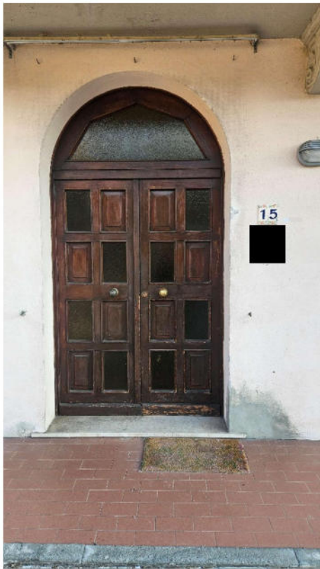
Portoncino d'ingresso condominiale
