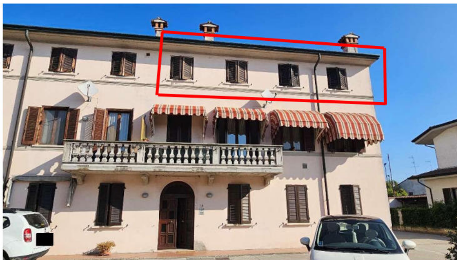
Facciata principale – prospetto lato Sud
