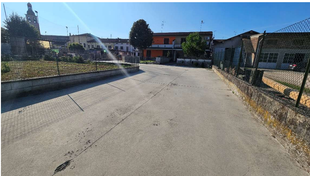
Strada interna di lottizzazione mapp. 838
