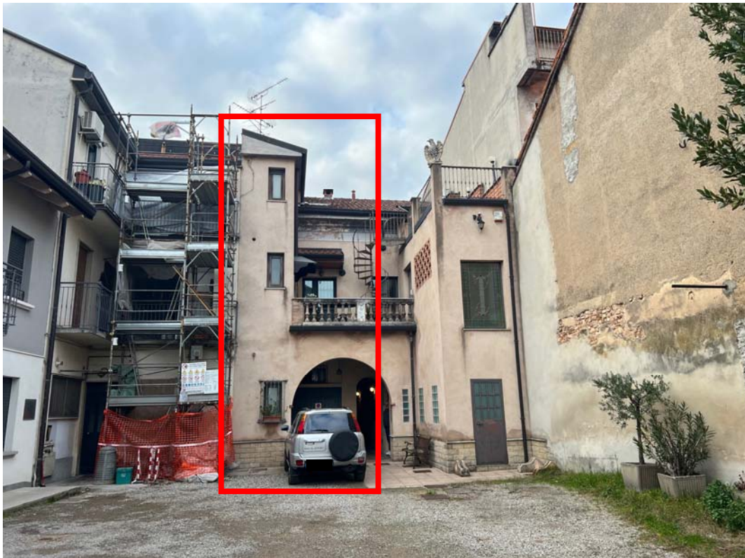
Fronte su cortile interno
