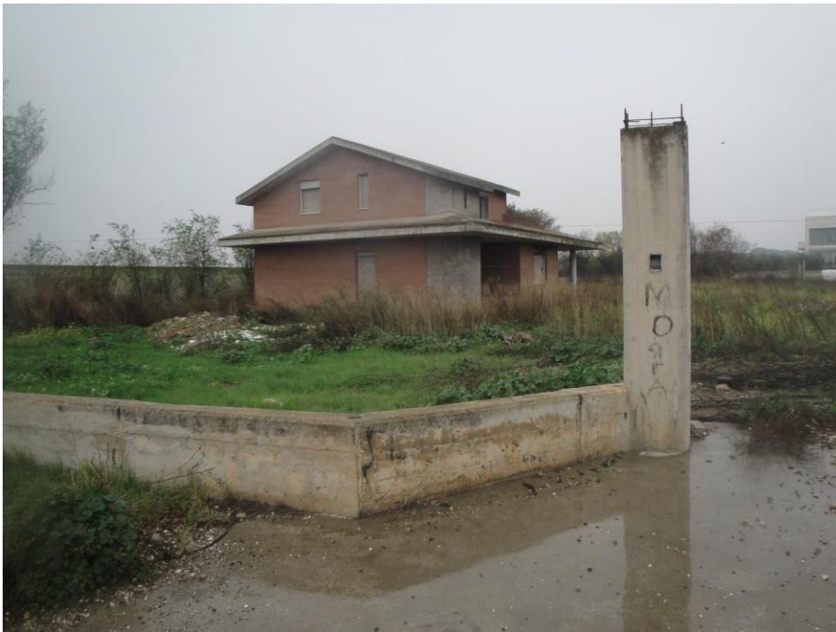
Particolare del corpo di fabbrica a rustico
