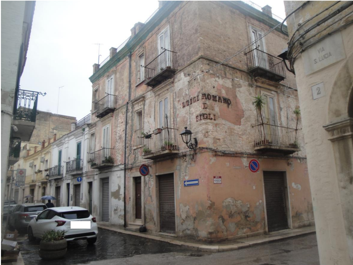
Foto 1: Comune di San Severo. Prospetti esterni del fabbricato di Via Roma 158 p. 2-3.
