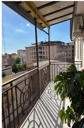
Balcone lato Sud
