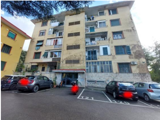
ingresso palazzina Q
