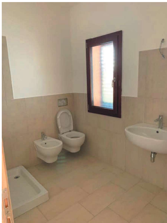
Foto n 5 Bagno
