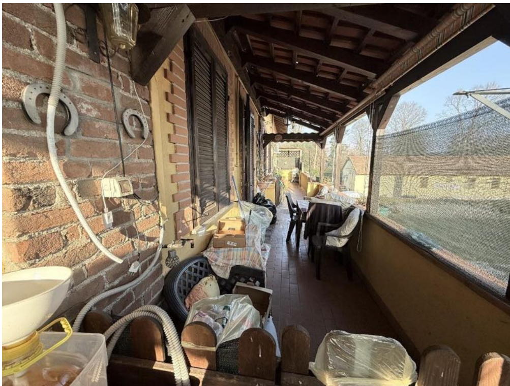
Piano Primo - Appartamento - Balcone (foto 2)
