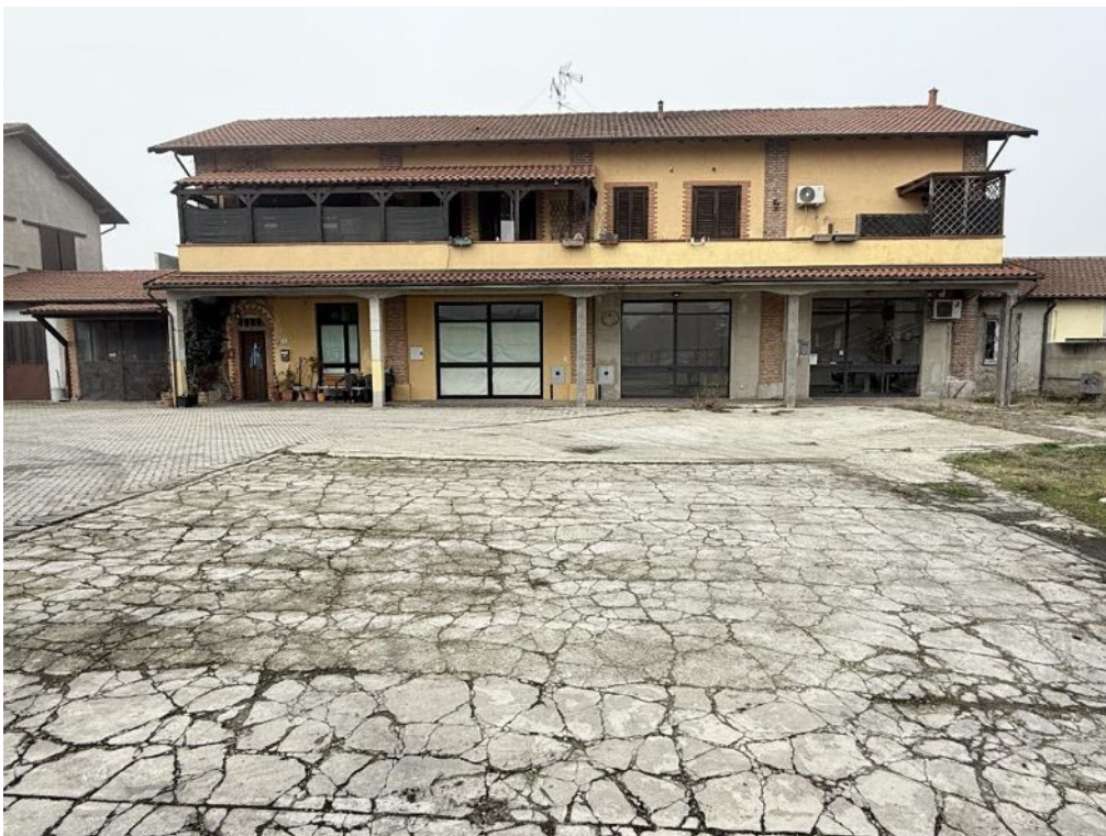
Fabbricato - Vista da area cortilizia comune (foto 2)
