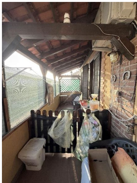
Piano Primo - Appartamento - Balcone (foto 3)
