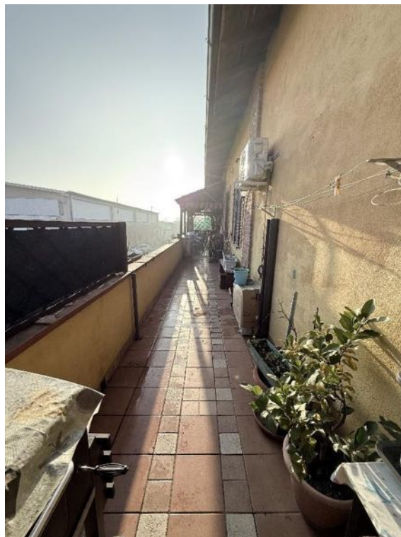
Piano Primo - Appartamento - Balcone (foto 5)
