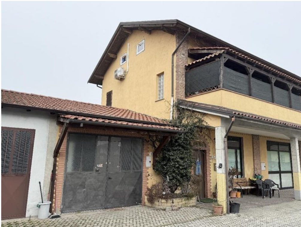
Fabbricato - Vista da area cortilizia comune (foto 7)
