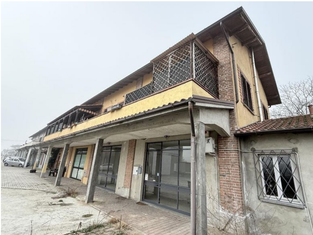
Fabbricato - Vista da area cortilizia comune (foto 4)
