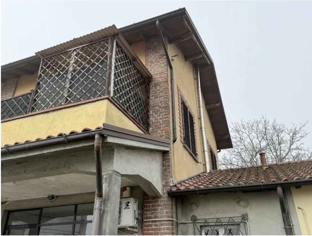
Fabbricato - Vista da area cortilizia comune (foto 5)
