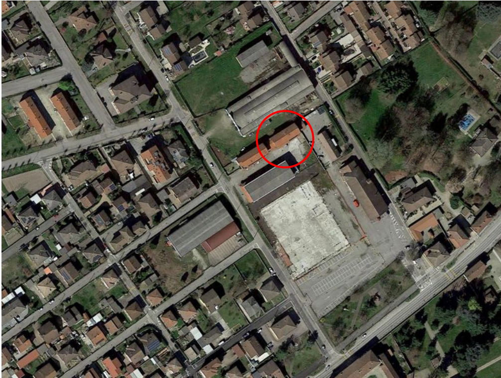
Fabbricato - Vista aerea (fonte: Google Earth©)
