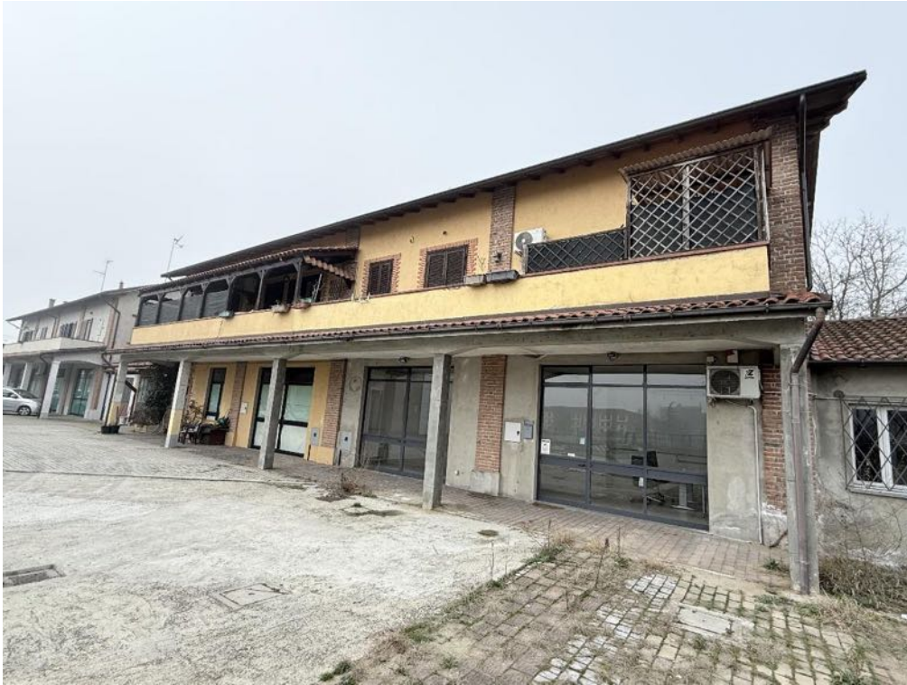
Fabbricato - Vista da area cortilizia comune (foto 3)
