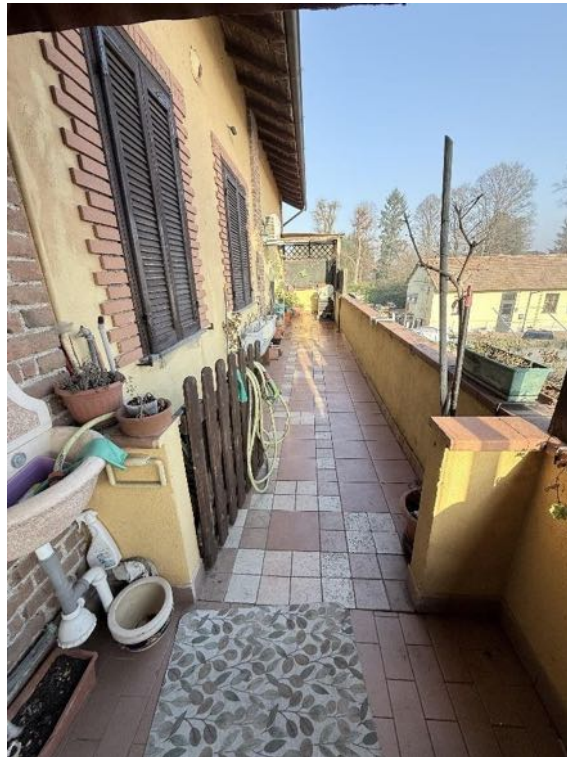
Piano Primo - Appartamento - Balcone (foto 4)
