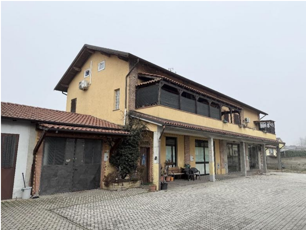
Fabbricato - Vista da area cortilizia comune (foto 1)
