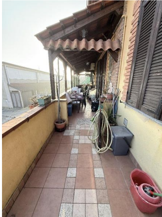
Piano Primo - Appartamento - Balcone (foto 6)
