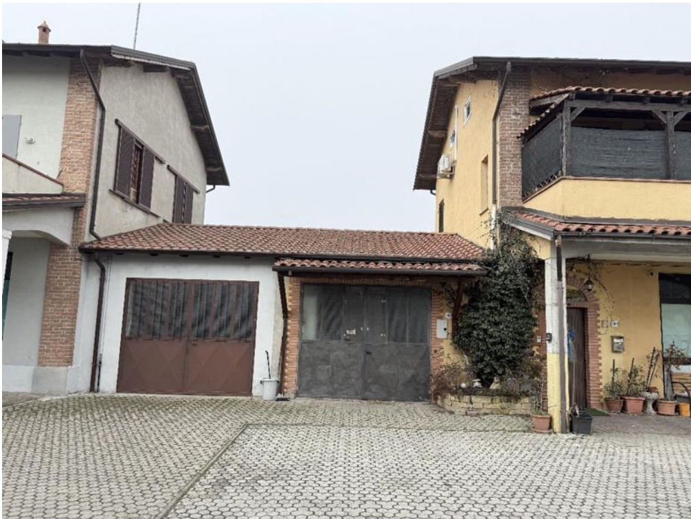
Fabbricato - Vista da area cortilizia comune (foto 6)
