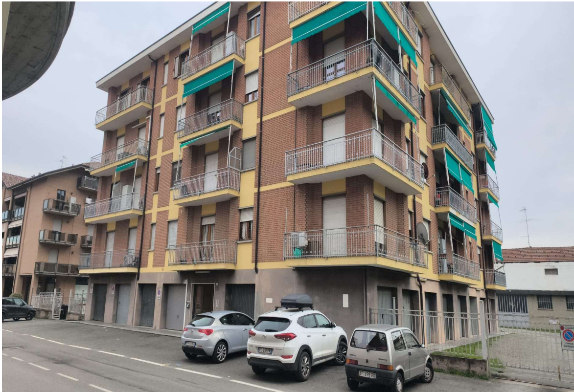
vista condominio lato Piazza Marconi
