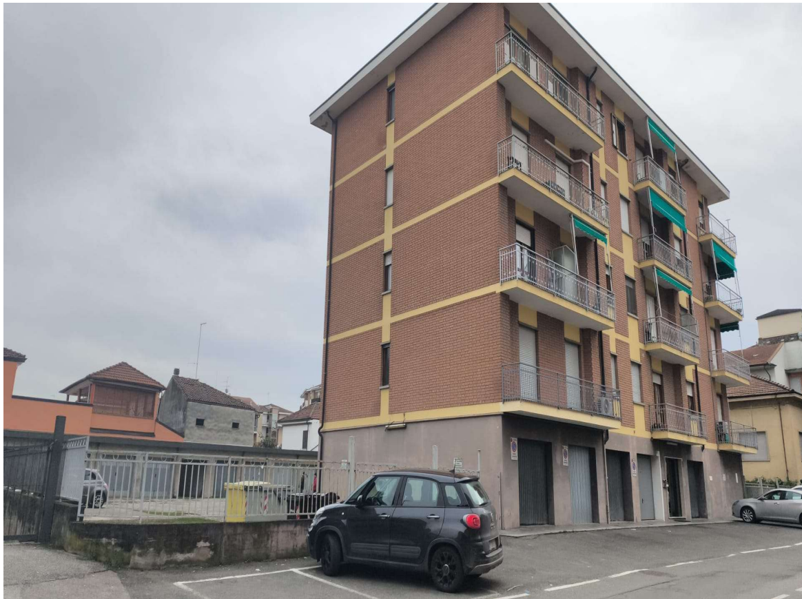
vista condominio lato Via Trento
