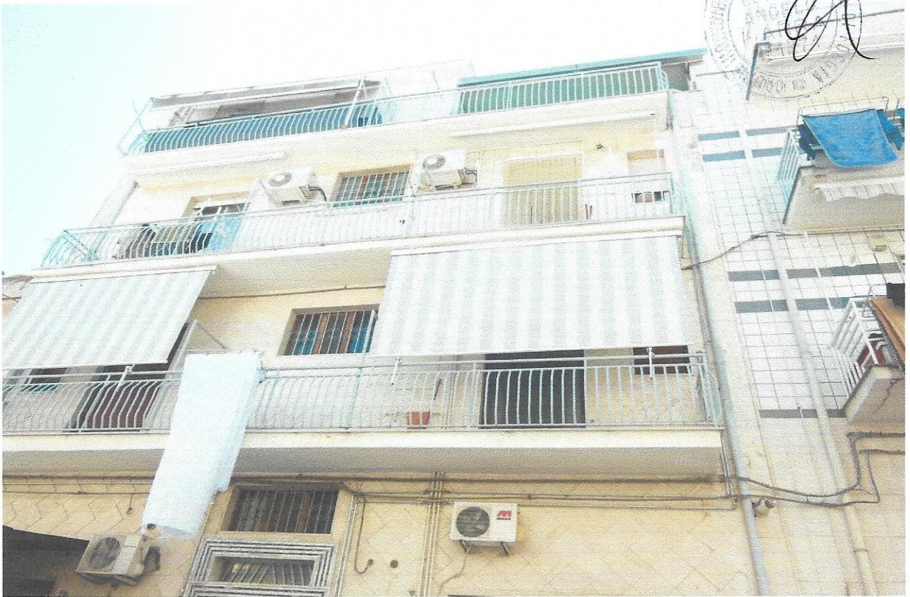
1 – Part. prospetto edificio su via Recanati
