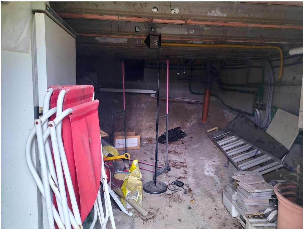
Foto 10: piano seminterrato - ripostiglio 2
