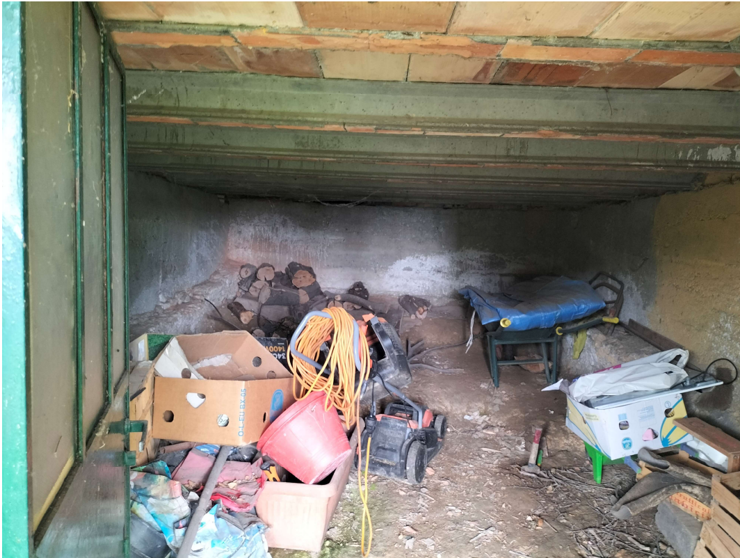
Foto 9: piano seminterrato - ripostiglio 1
