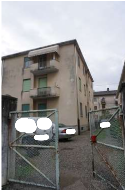
Foto 2: Prospetto nord/ovest su via Ettore Bossi e accesso carraio.
