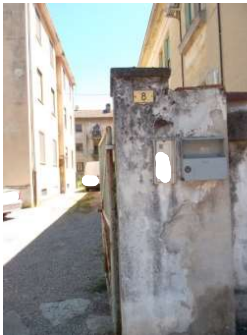
Foto 3: Accesso carraio e pedonale da via E. Bossi n. 8.
