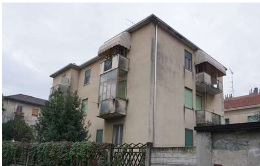
Foto 1: Prospetto nord/est in angolo tra via Viglio e via Bossi.
