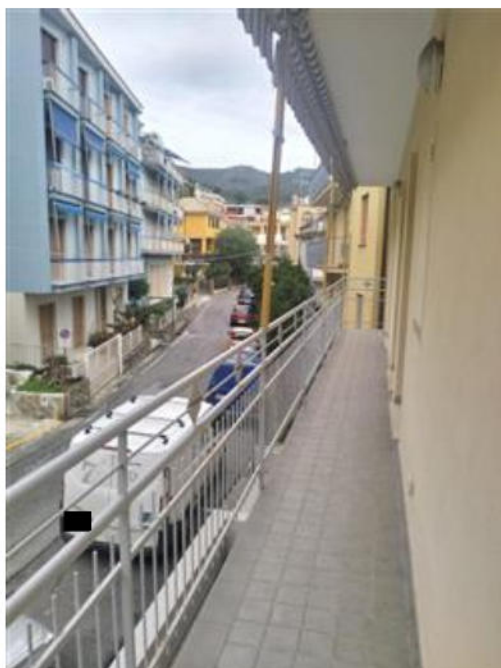
Balcone lato ovest
