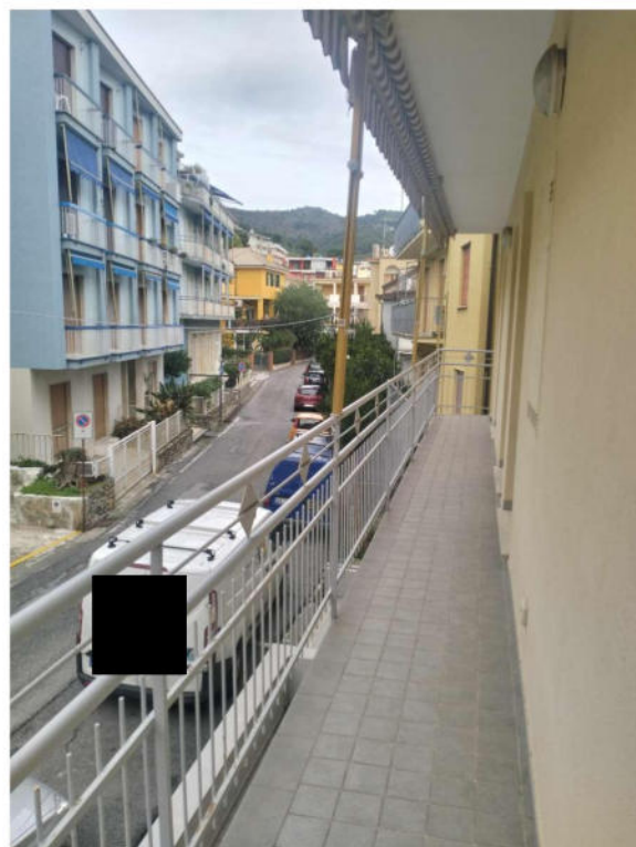
15) Balcone sul prospetto ovest
