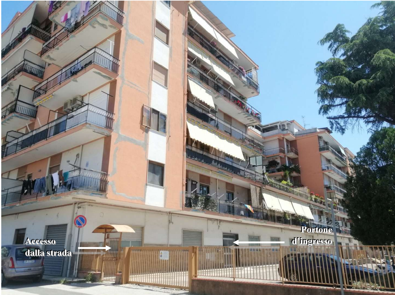
Foto esterna del Fabbricato
