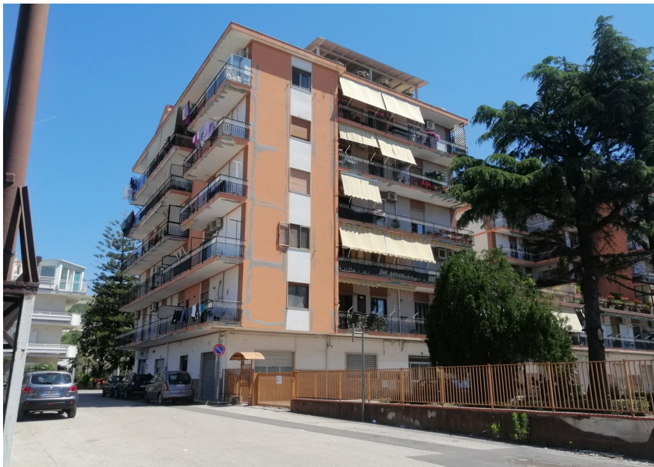
Foto esterna del fabbricato
