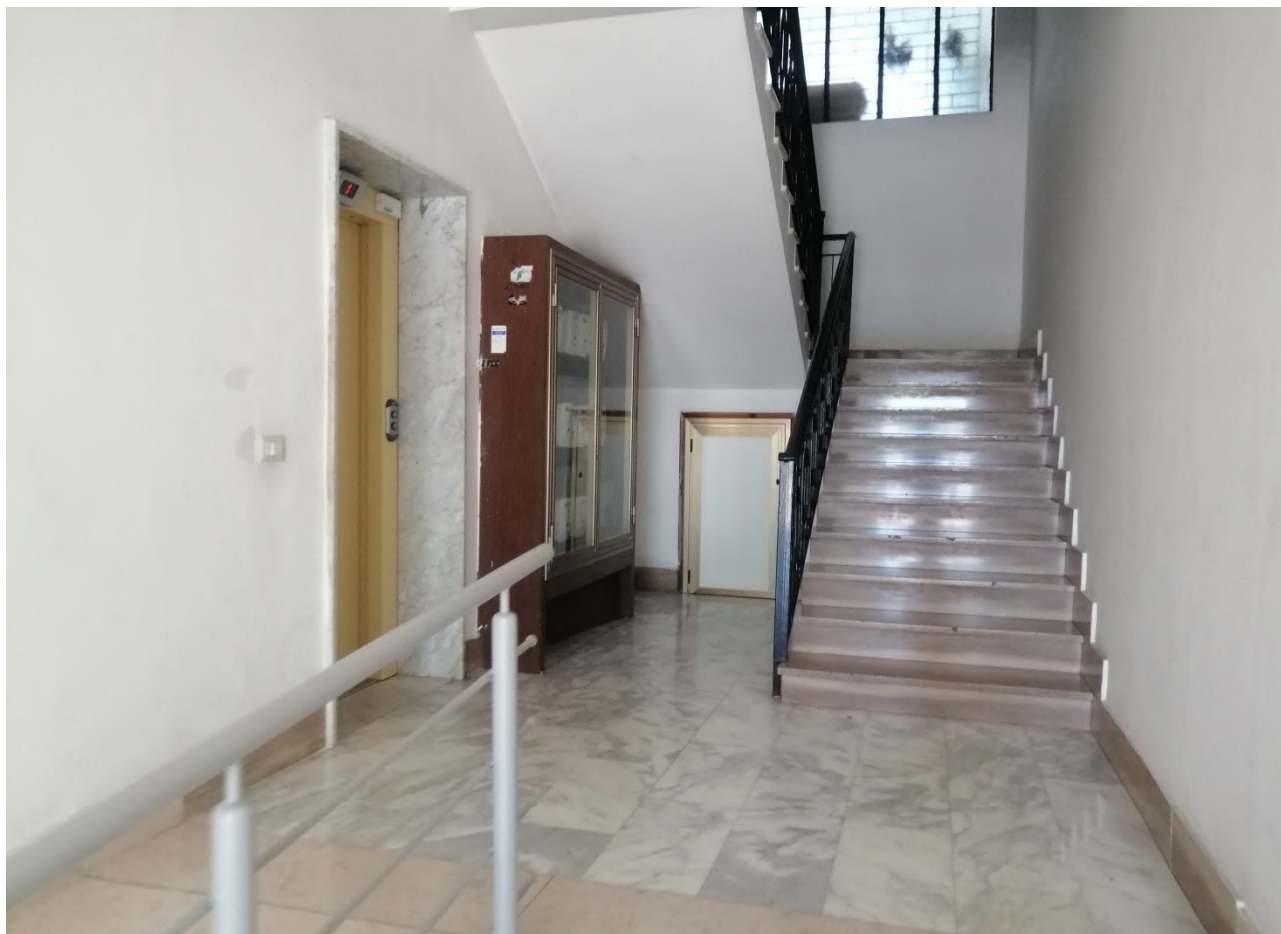
Foto del vano scala di ingresso
