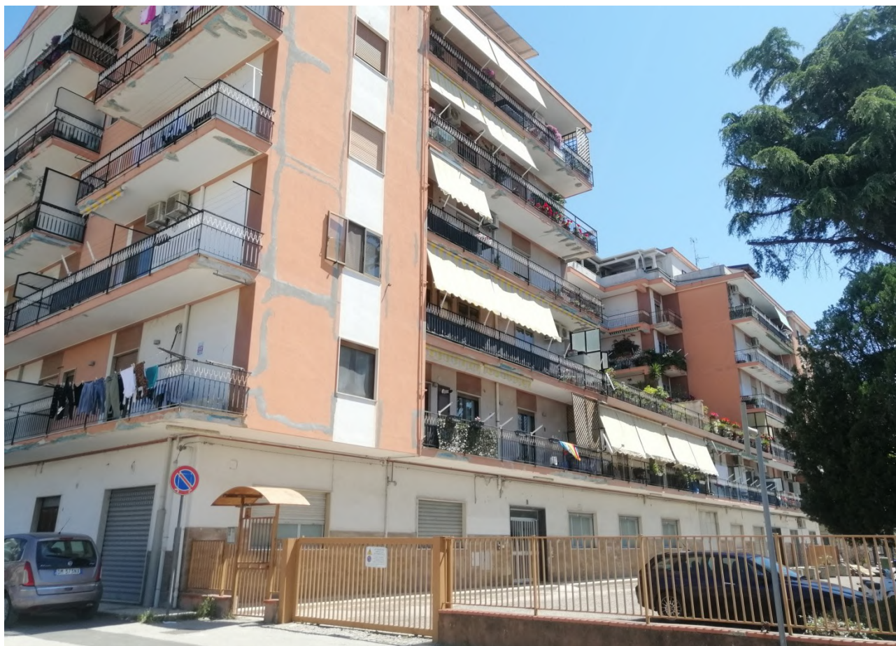
Foto esterna del fabbricato
