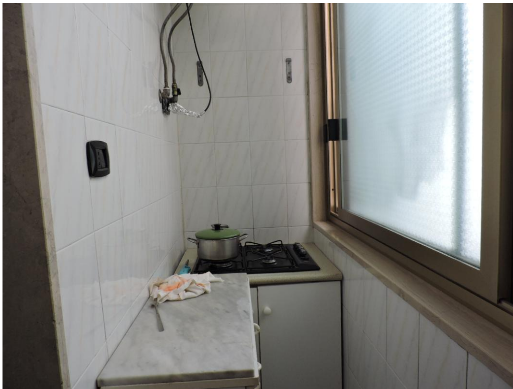
Veduta dall'interno del tinello verso il balcone verandato. Veranda.
