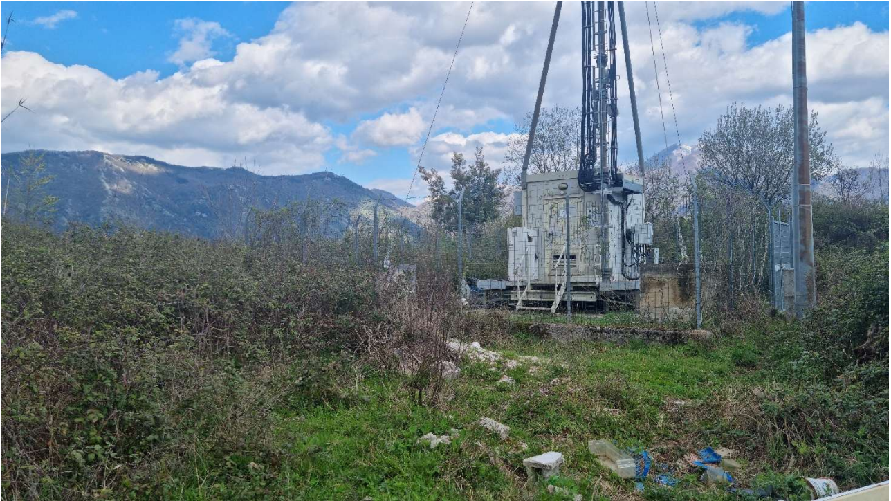
Ril. Fot. 4 stazione radio
