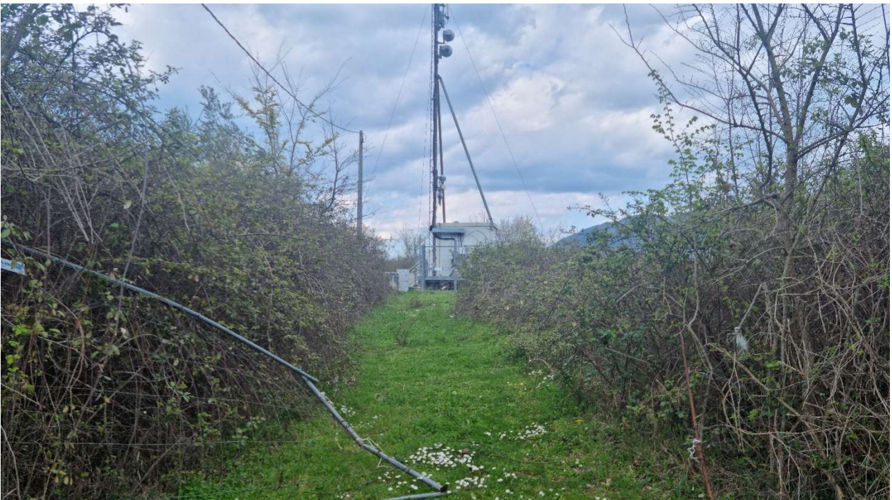
Ril. Fot. 5 accesso stazione radio da strada Carmine Molinari
