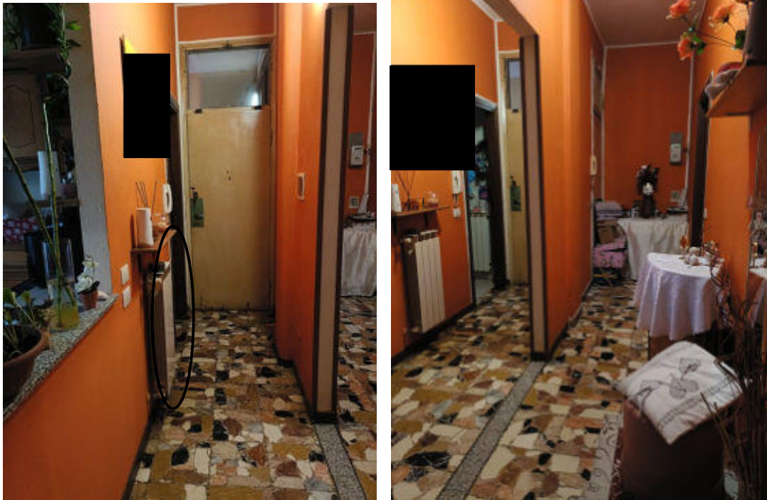
Corridoio centrale con evidente la demolizione della parete divisoria
