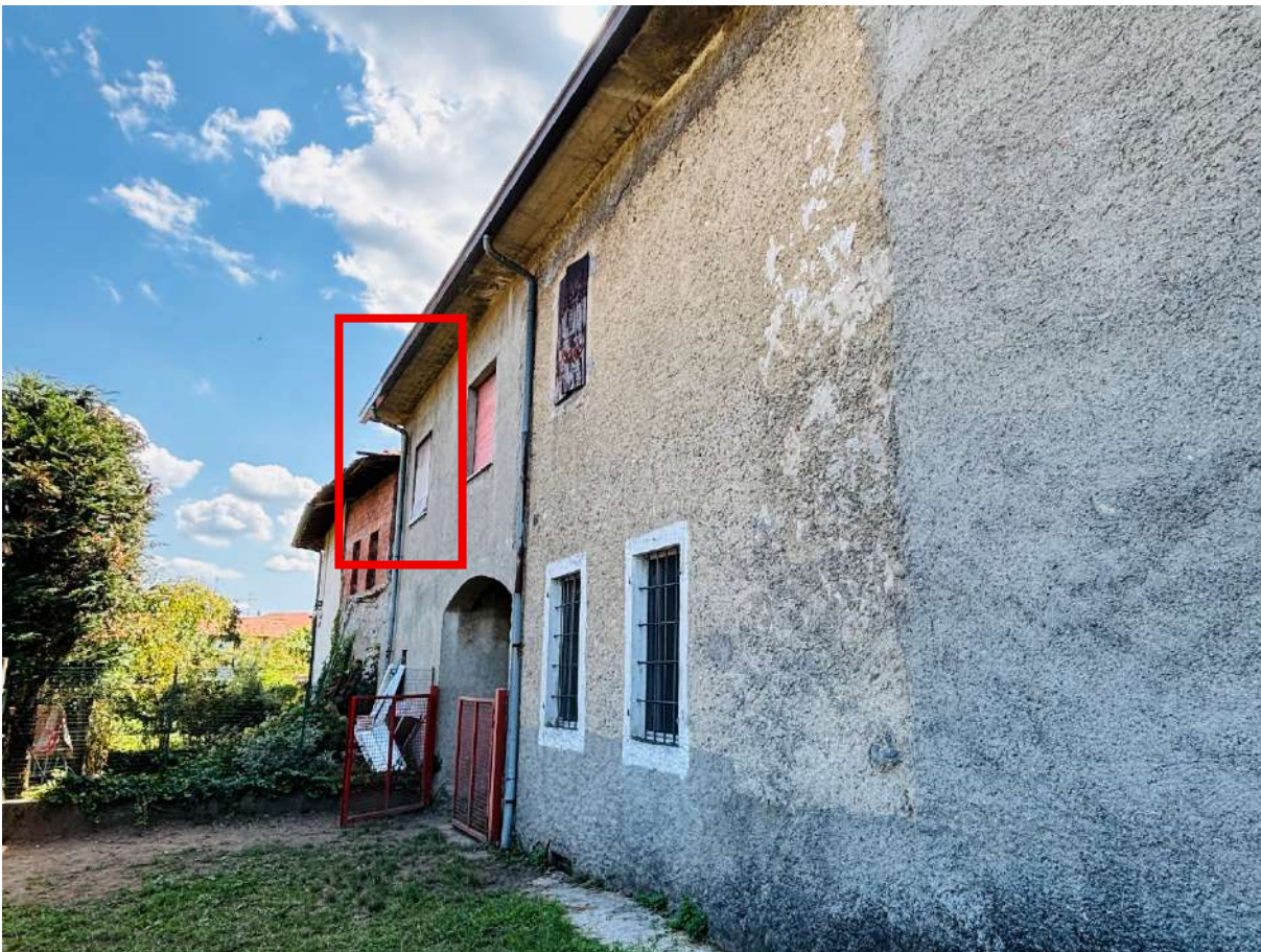
Fotografia 20. Lotto B. Appartamento a piano primo. Retro.
