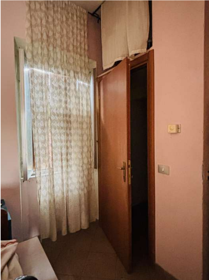
Fotografia 17. Lotto A. Ingresso al bagno.
