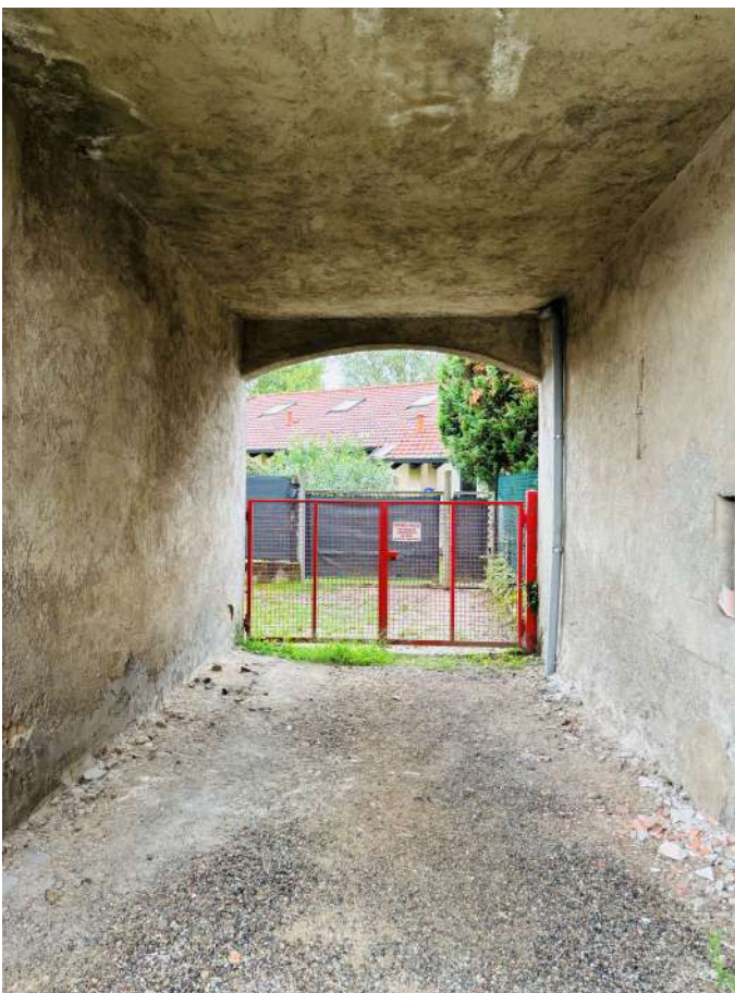
Fotografia 41. Lotto A e B. Accesso al retro.
