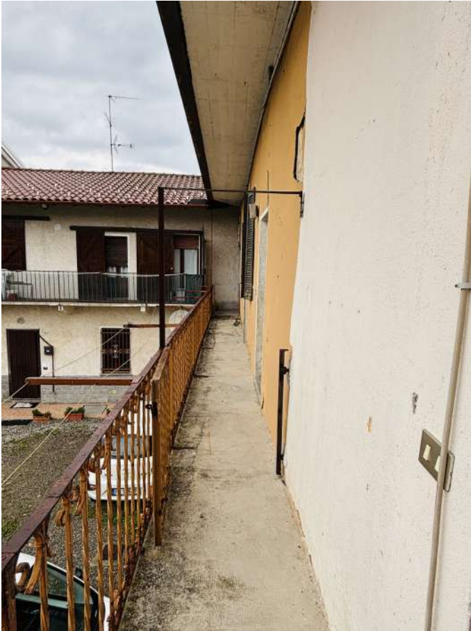
Fotografia 41. Lotto B. Ballatoio comune.
