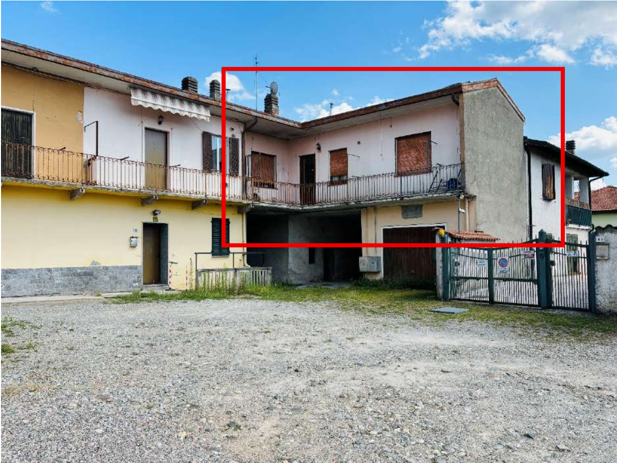
Fotografia 19. Lotto B. Appartamento a piano primo. Fronte.
