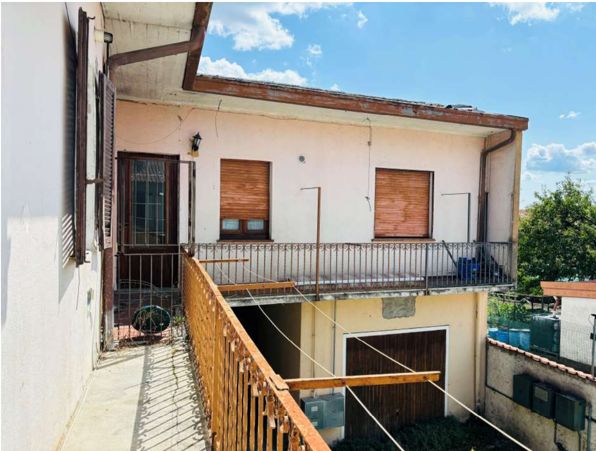
Fotografia 21. Lotto B. Appartamento a piano primo. Vista da ballatoio comune.
