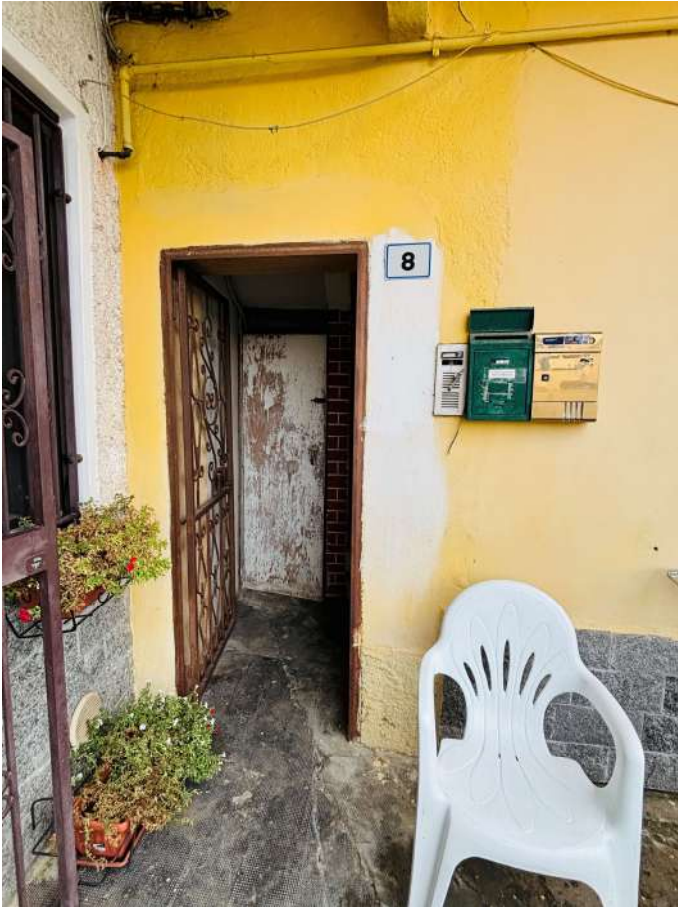
Fotografia 05. Lotto A. Accesso alla scala comune.
