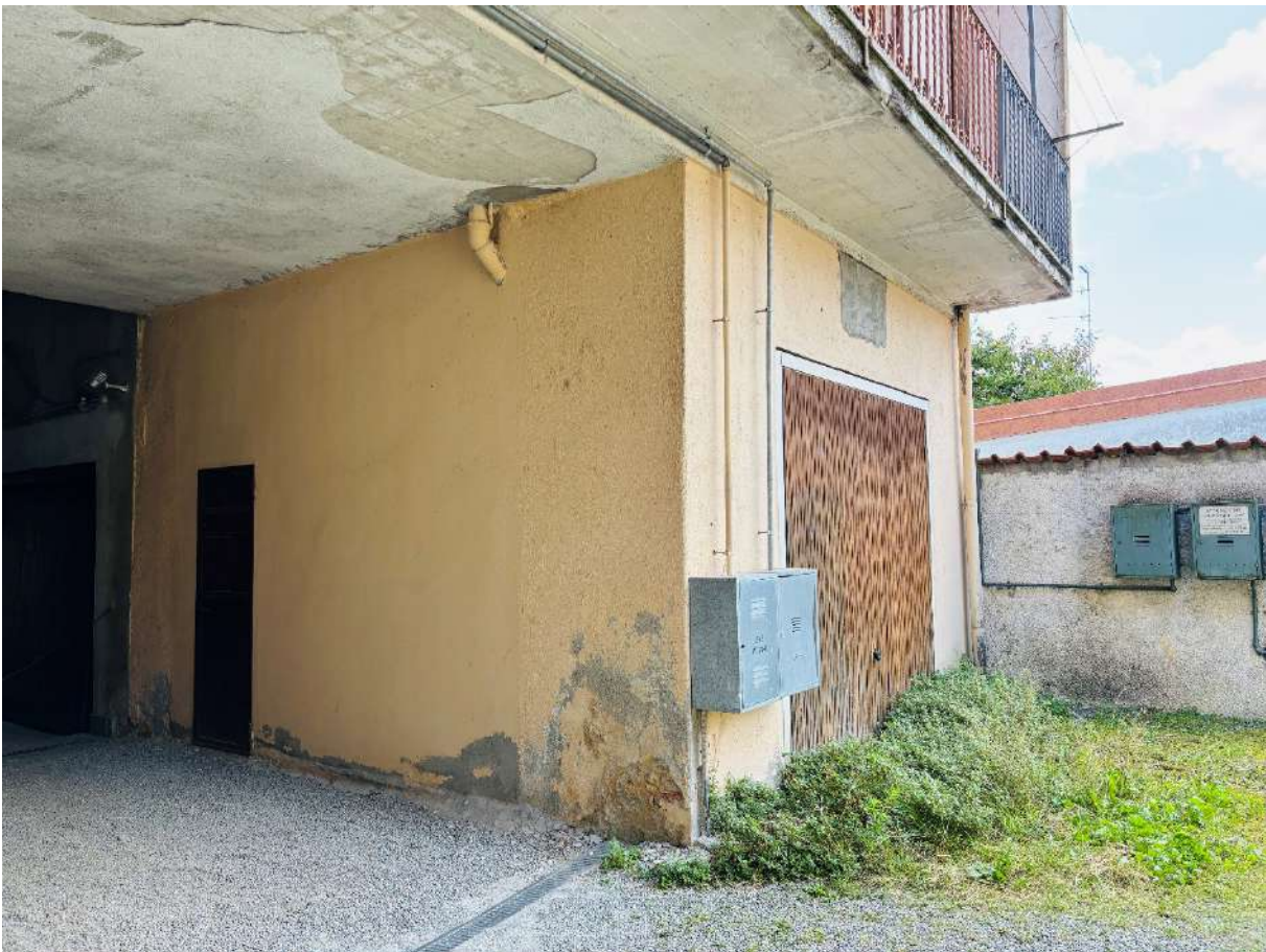
Fotografia 44. Lotto C. Autorimessa.
