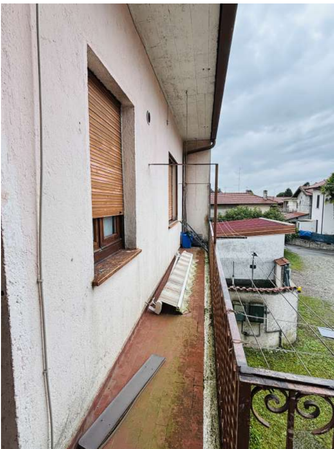
Fotografia 24. Lotto B. Balcone.
