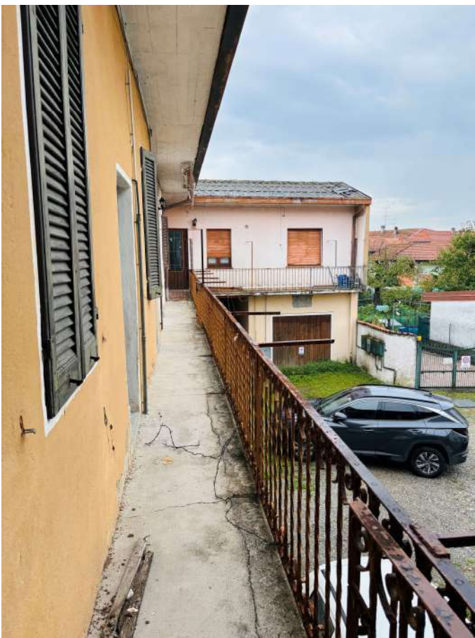
Fotografia 08. Lotto A. Ballatoio comune.
