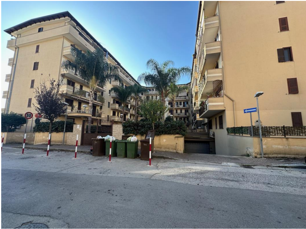
Foto 1: vista del fabbricato dal viale condominiale
