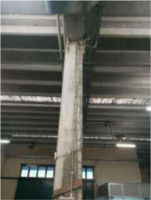
Piano terra capannone, infiltrazioni di acqua meteorica dalla copertura (già oggetto di intervento, evidentemente non risolutivo)
