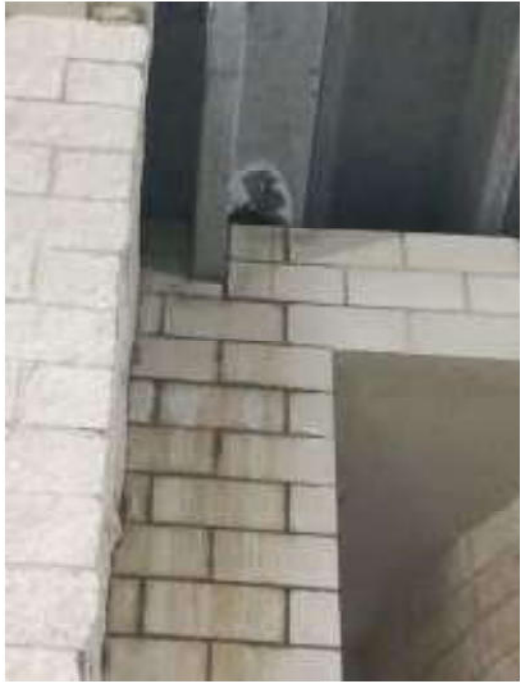
Piano terra capannone, infiltrazioni di acqua meteorica dalla copertura (già oggetto di intervento, evidentemente non risolutivo)
