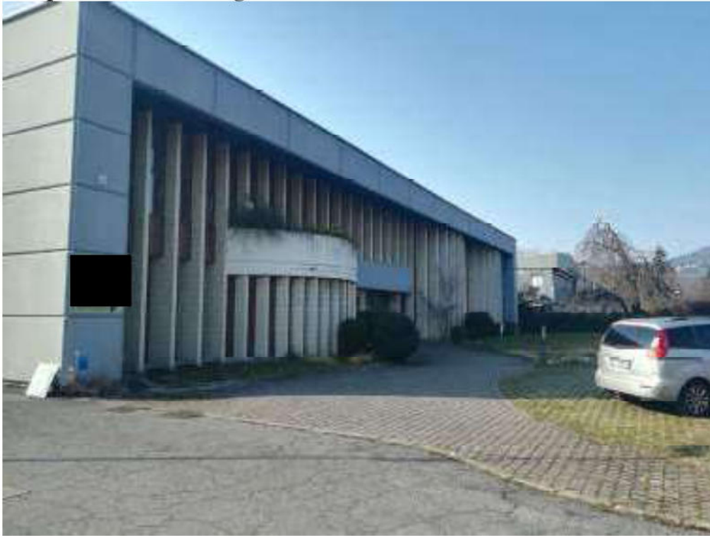
Prospetto NORD sull'ingresso
