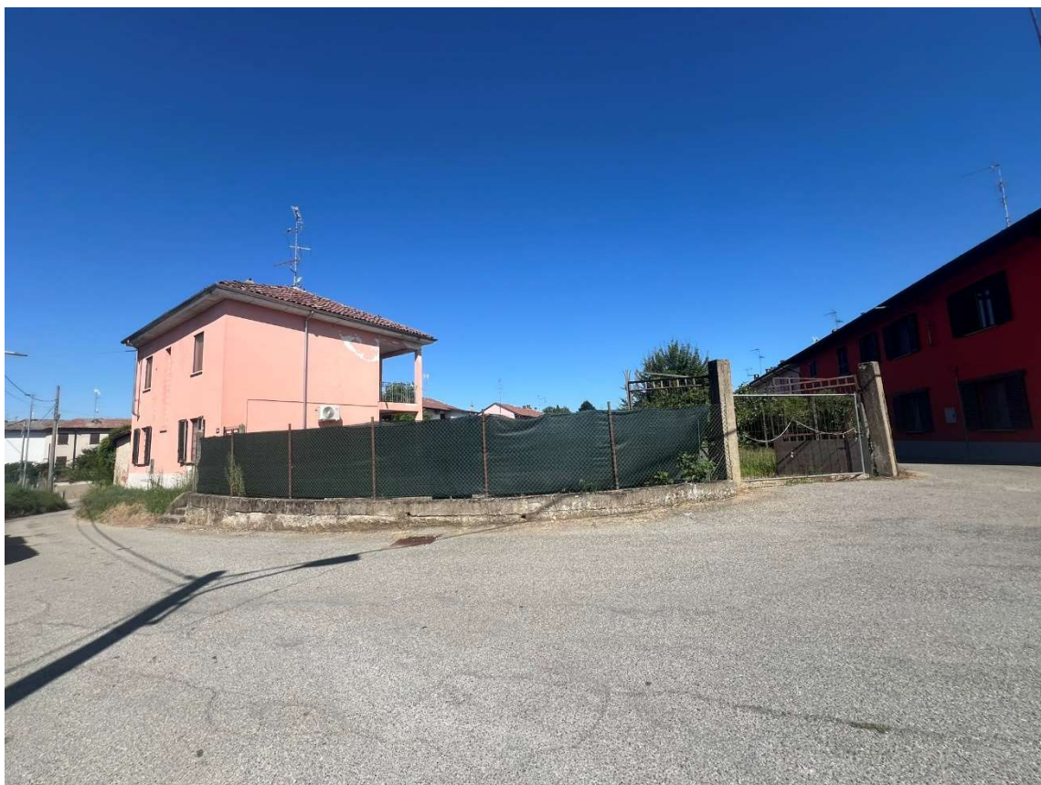
Vicolo Ossario – immobile affaccio su strada
