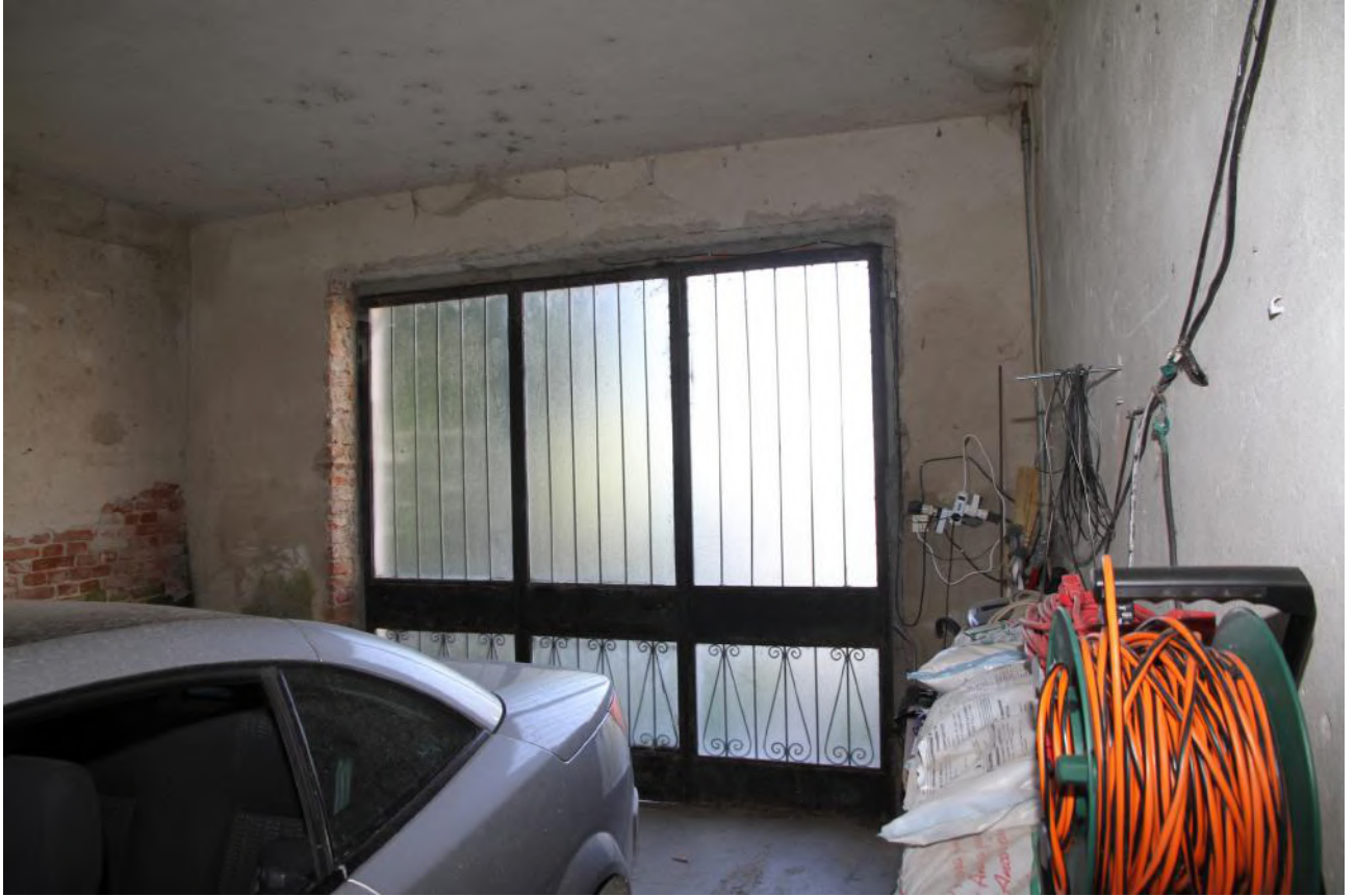
Foto n° 30 - Piano terreno - attuale destinazione box
