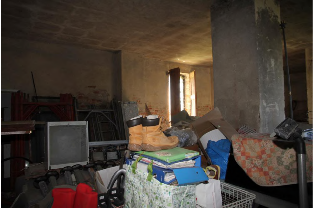
Foto n° 26 - Piano terreno - attuale destinazione sgombero
