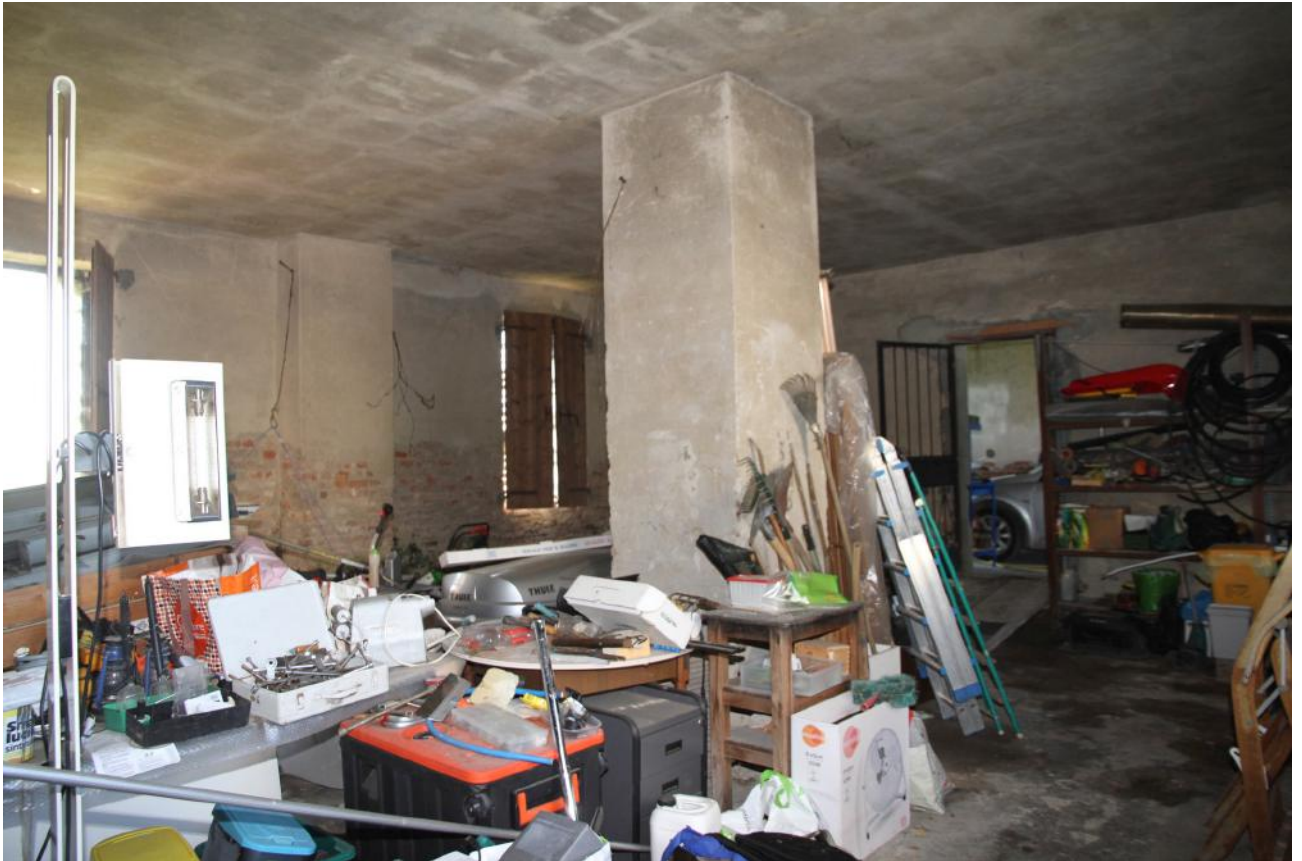
Foto n° 28 - Piano terreno - attuale destinazione sgombero
