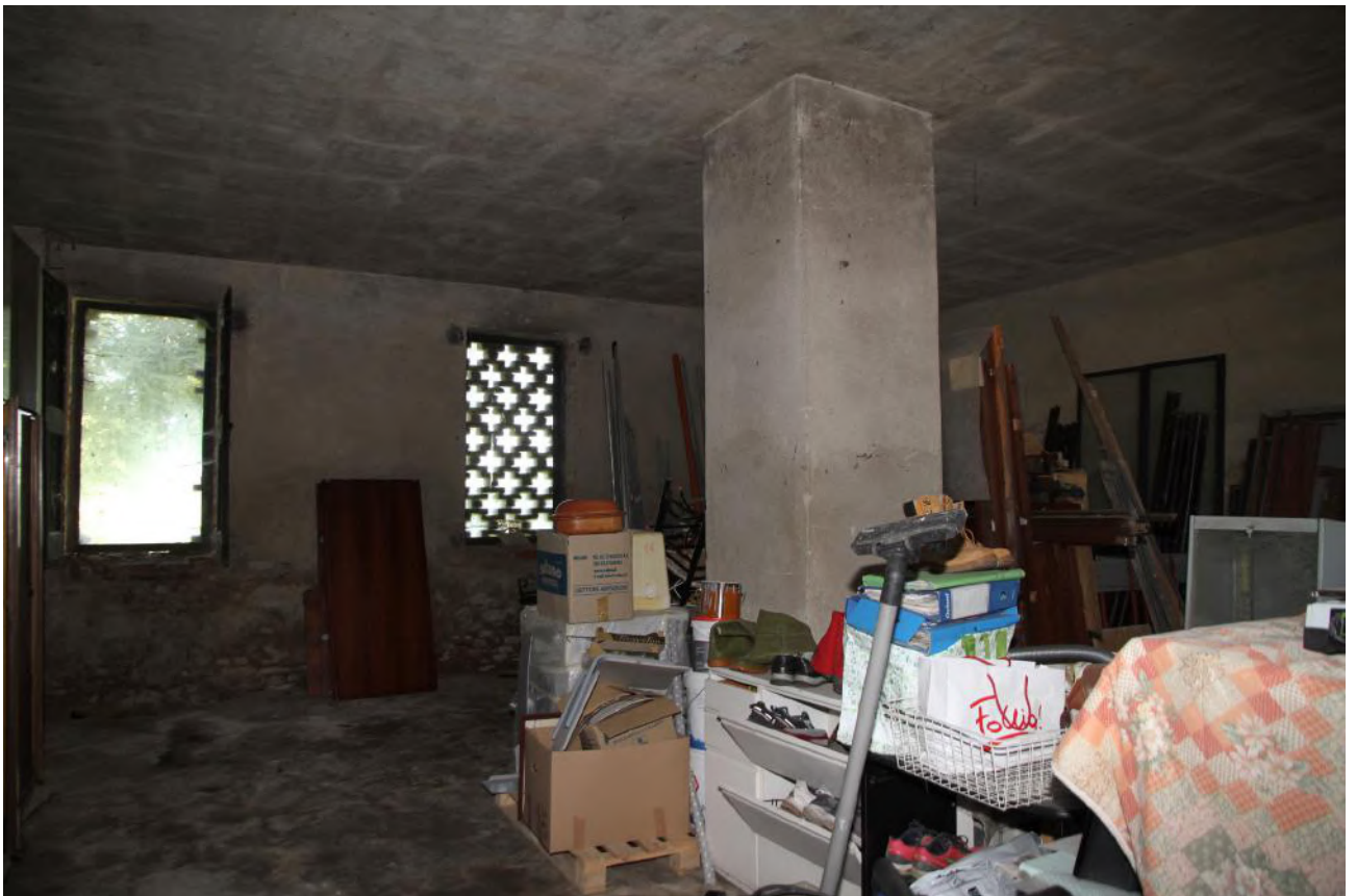
Foto n° 25 - Piano terreno - attuale destinazione sgombero
