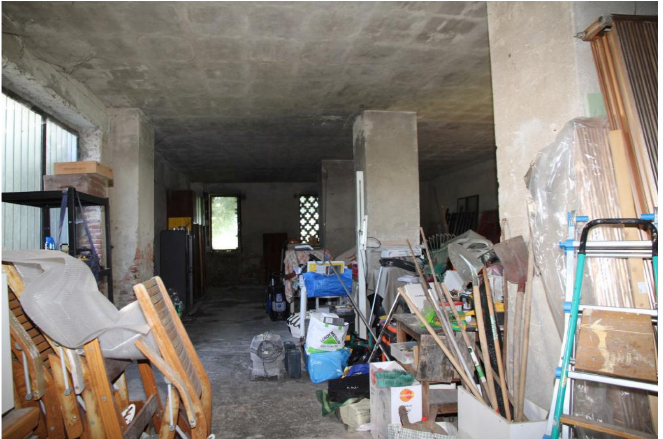
Foto n° 23 - Piano terreno - attuale destinazione sgombero
