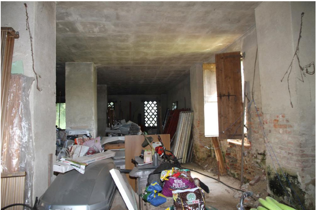
Foto n° 22 - Piano terreno - attuale destinazione sgombero
