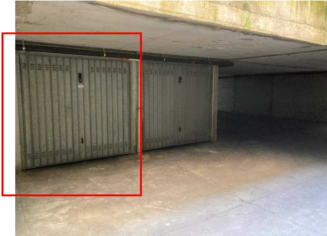
Foto n. 7: Corsia comune - piano primo interrato.
