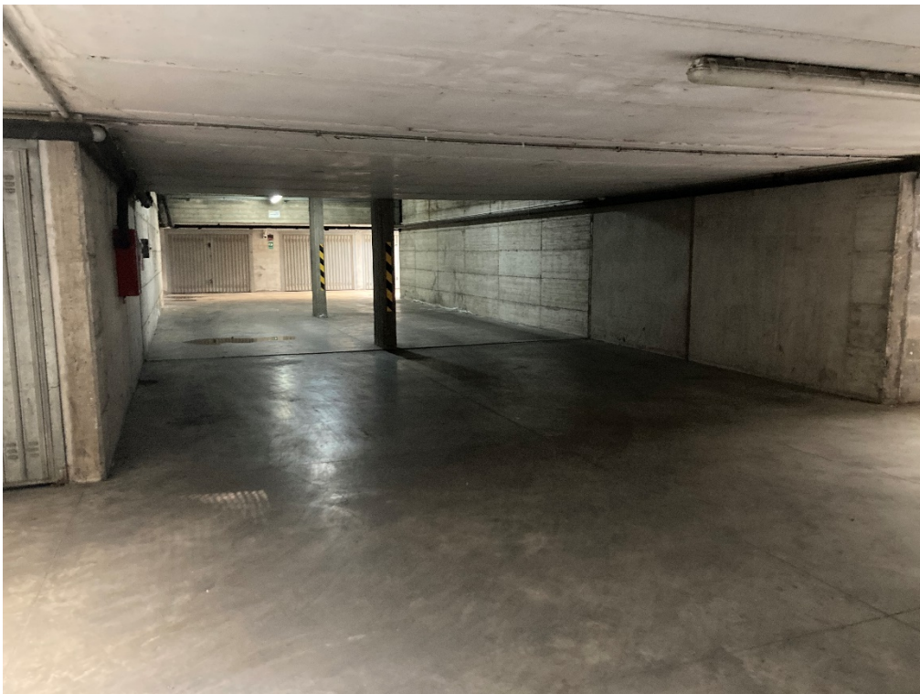
Foto n. 6: Corsia comune - piano primo interrato.
