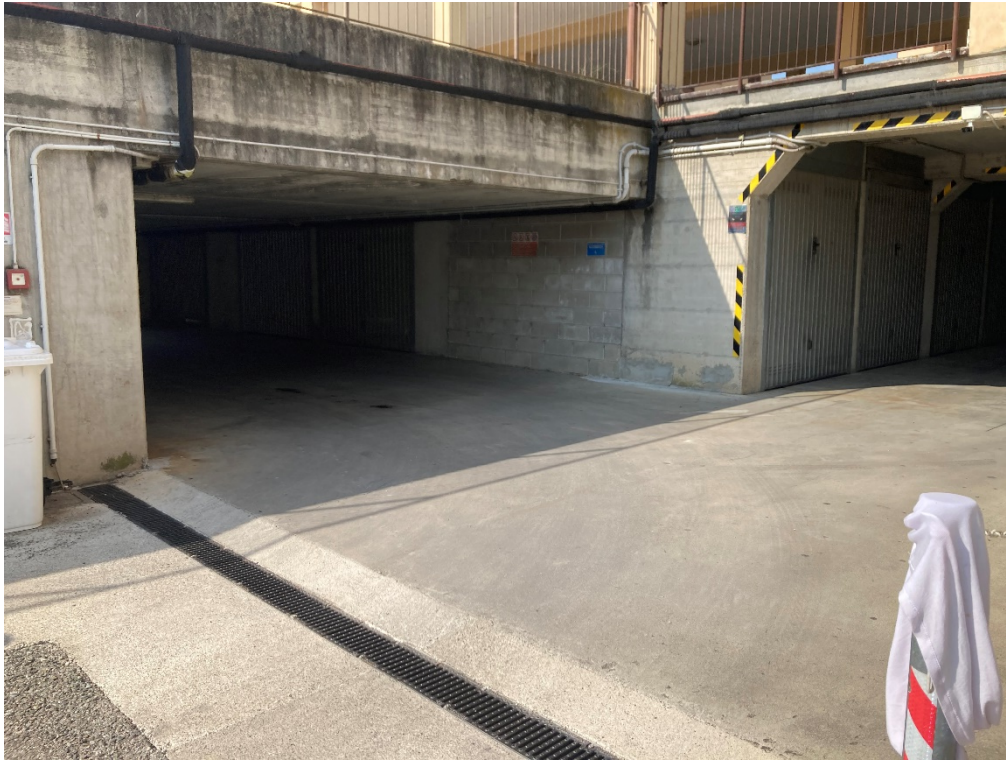
Foto n. 3: Corsia comune - piano primo interrato.
