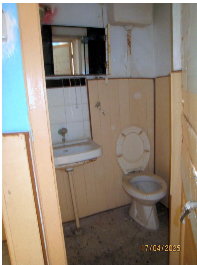
Foto n. 6. Il piccolo w.c. nel sotto scala.
