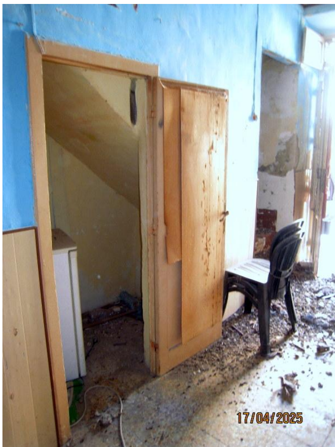
Foto n. 5. Il minuscolo ripostiglio nel sotto scala.
