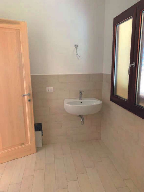
Foto n 5 bagno
