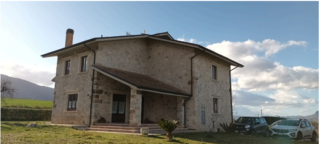
Vista esterna – spigolo S/E
