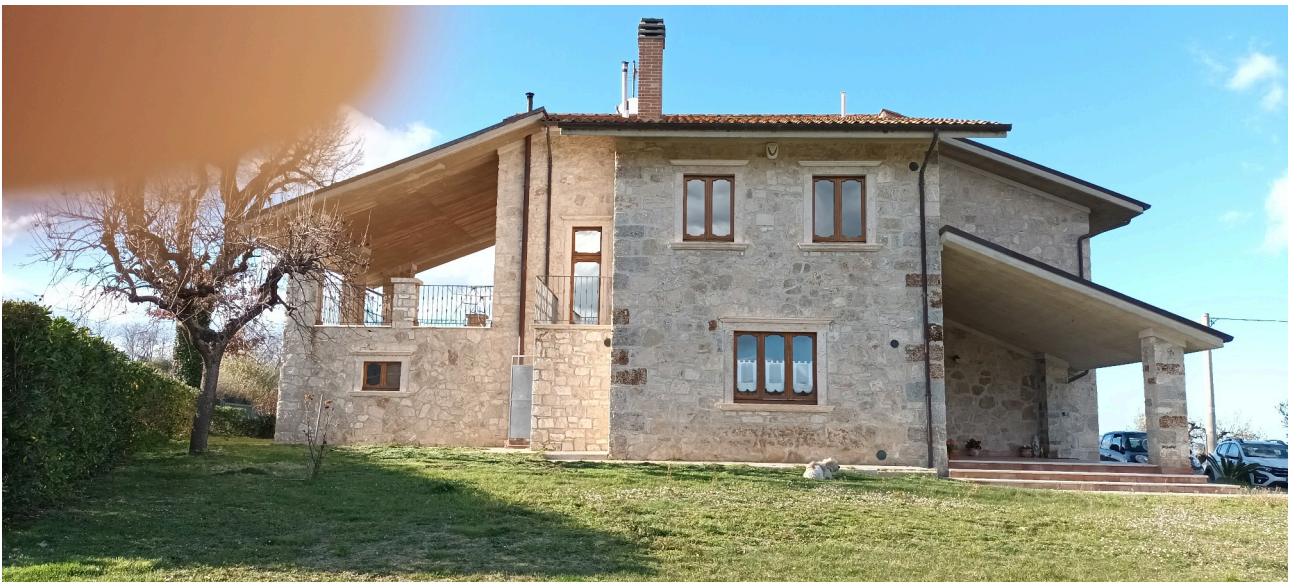
Vista esterna – facciata Sud
