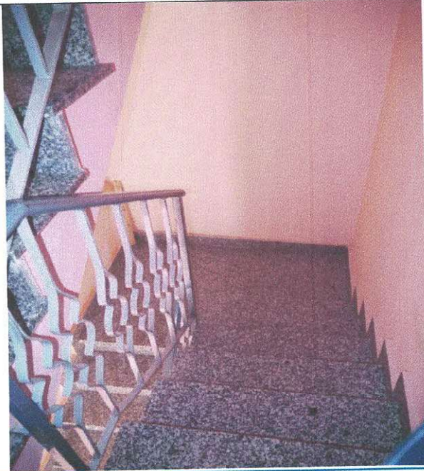
N° 3 Foto Interni Corpo scala di accesso al P1
