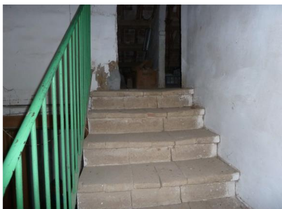
Accesso alla soffitta
