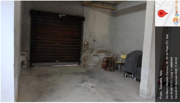
Ingresso carrabile comune all'autorimessa
