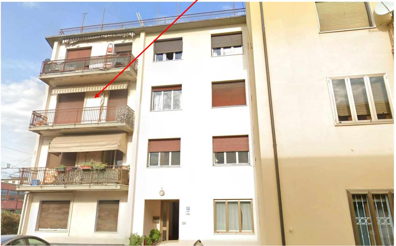
Facciata, ingresso comune da via M.M. Panconi 26 – Quartiere in oggetto P. 3°
