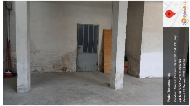
Ingresso pedonale interno autorimessa
