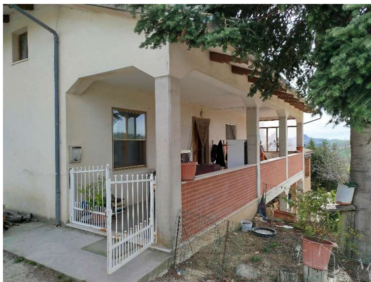
Figura 6 _ ingresso principale edificio (Sub.20 NON oggetto di perizia)
