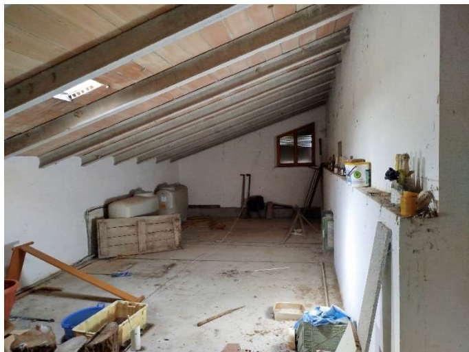
Figura 13 _ Interno soffitta Piano secondo (porzione in oggetto Sub.21)
