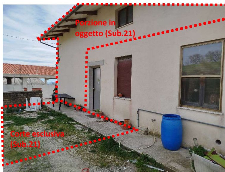
Figura 5 _ Esterno edificio con indicazione della porzione in oggetto (Sub.21)
