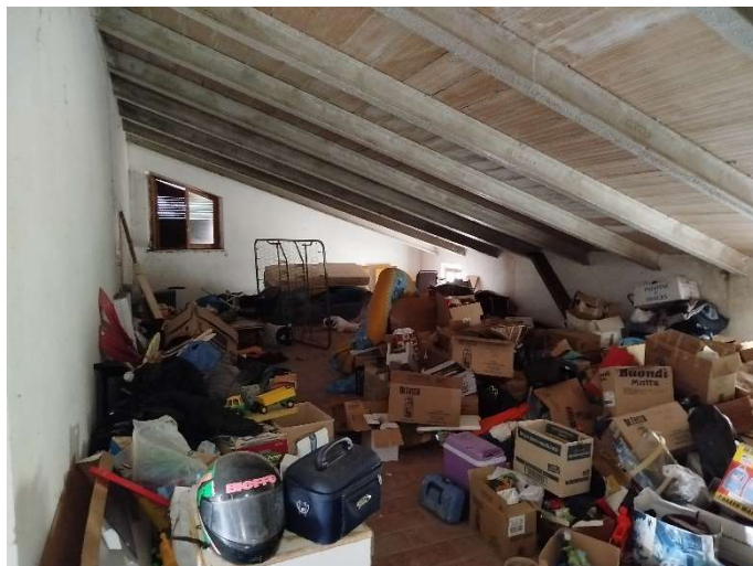
Figura 12 _ Interno soffitta Piano secondo (porzione in oggetto Sub.21)
