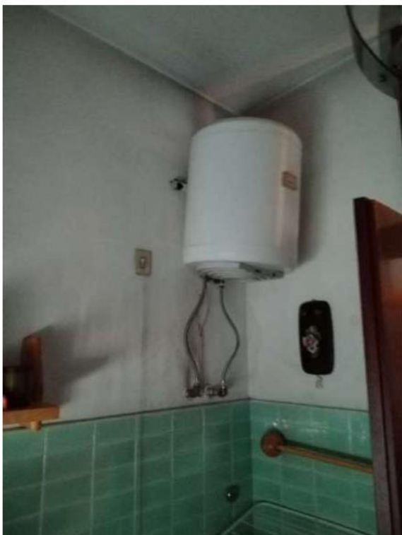
20) Bagno di servizio;
