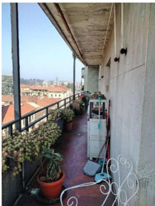
11) Vista di controcanto del balcone,
