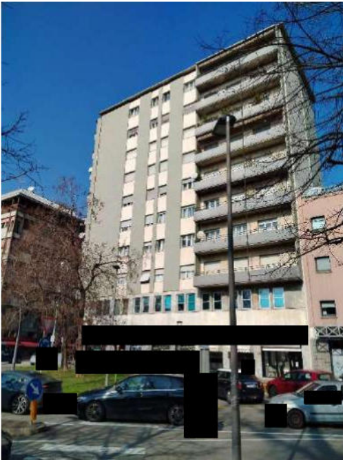
1) Vista del fabbricato da P.zza Risorgimento,
