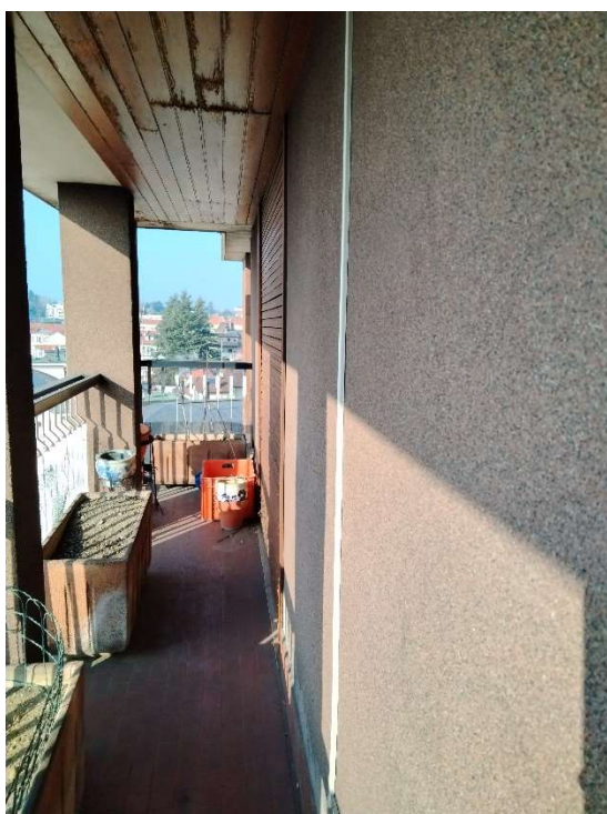
12) Balcone su P.zza Risorgimento;
