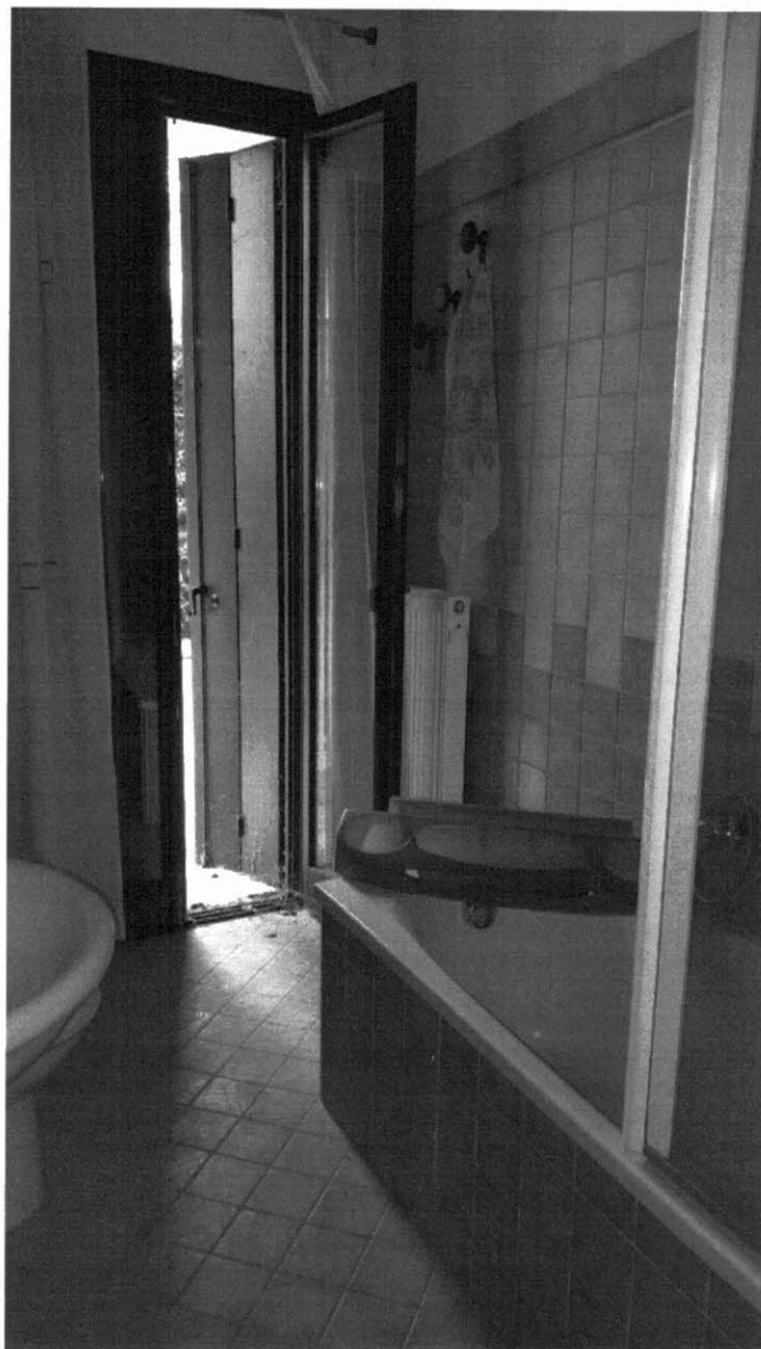
FOTO 29_Interno del locale bagno
