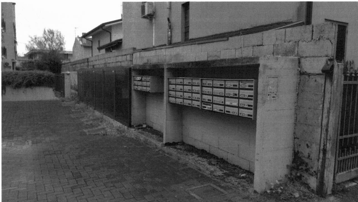
FOTO 10_Collocazione cassette postali
