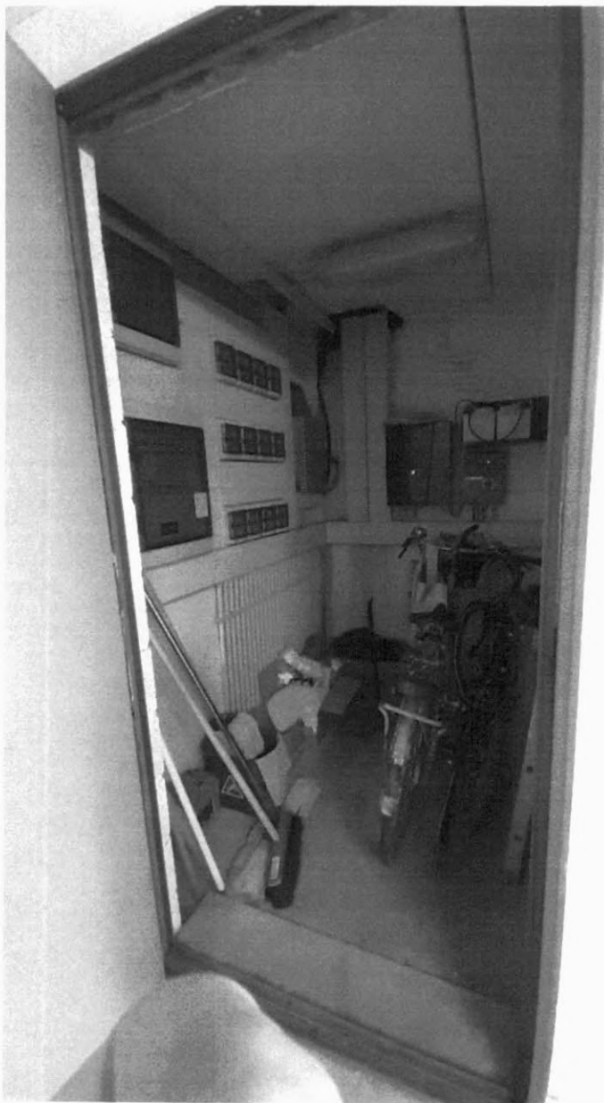
FOTO 23_Piano interrato_Vano contatori
