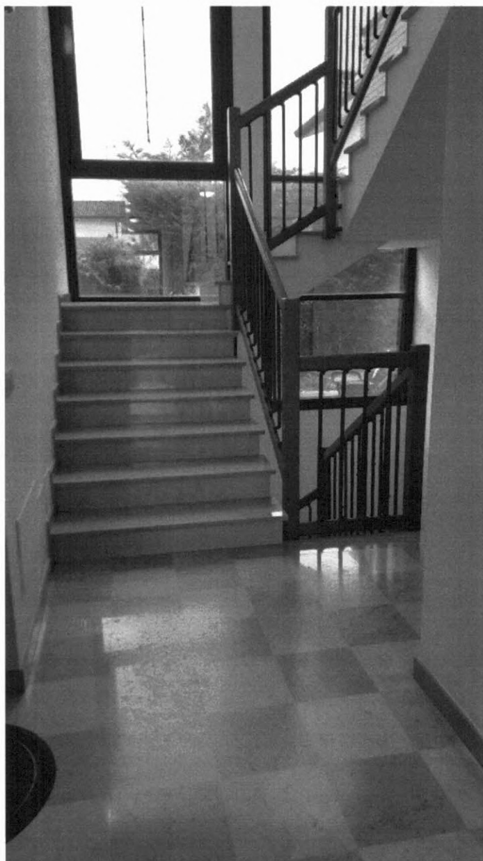
FOTO 12_Vano scala condominiale
