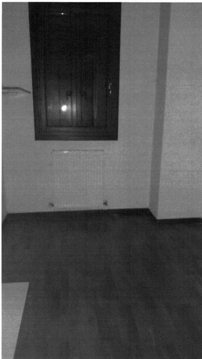
FOTO 31_Interno locale ripostiglio
