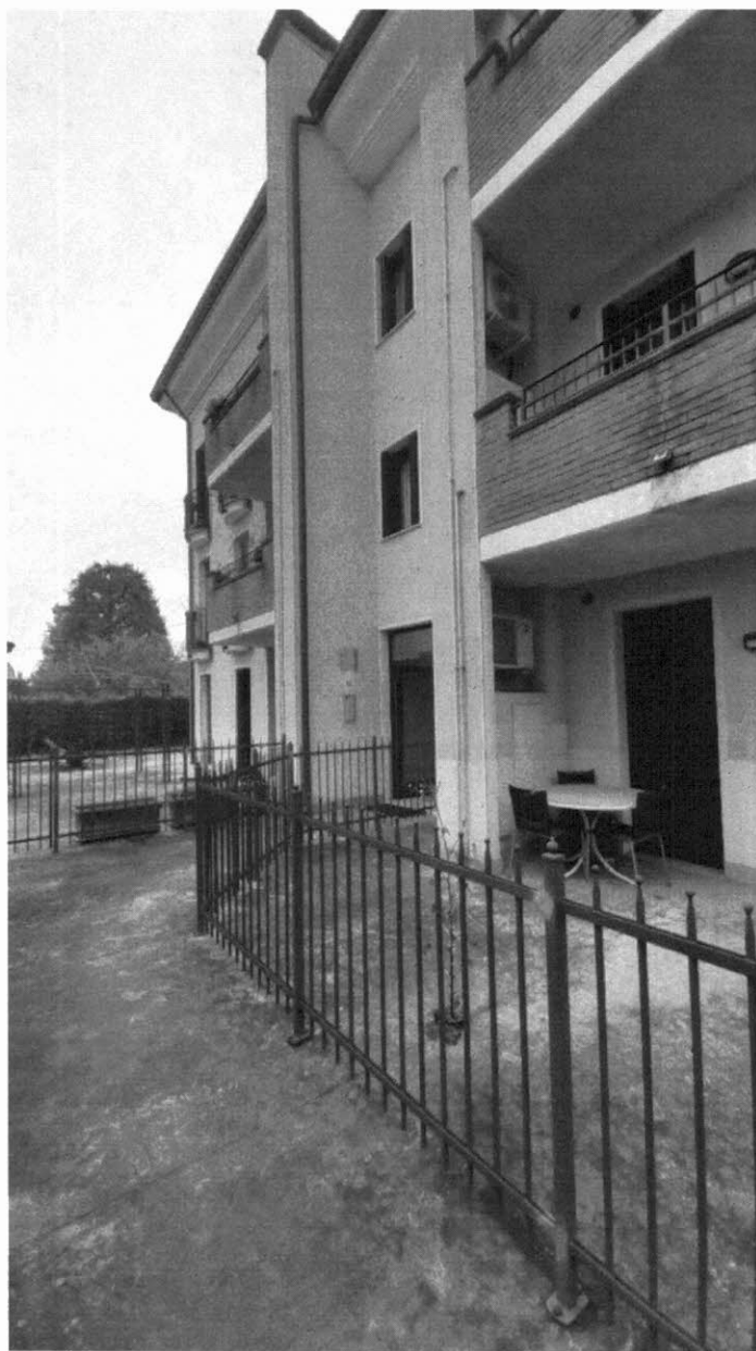
FOTO 7_Prospetto Nord_Accesso condominiale
