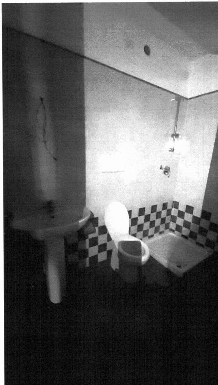
FOTO 28_Interno del locale WC
