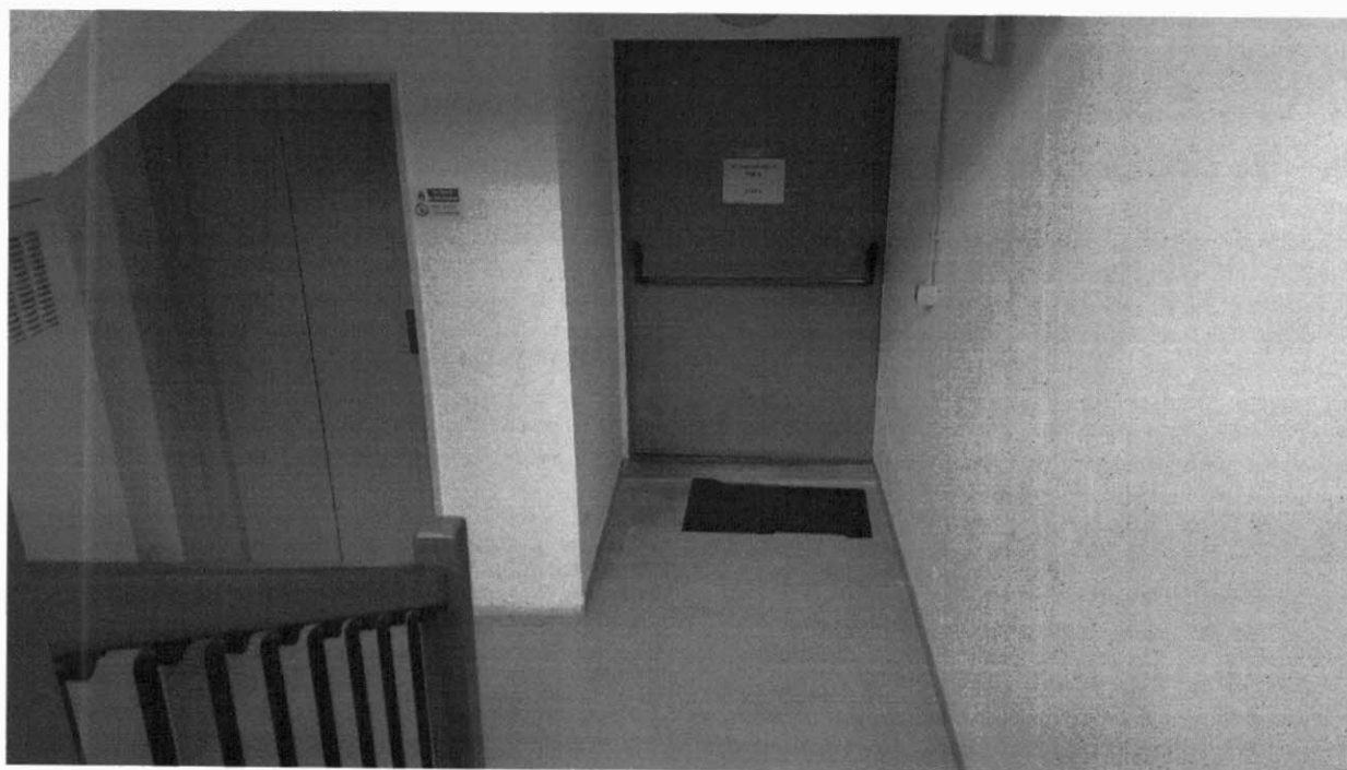
FOTO 15_Piano interrato_zona antistante ascensore e porta REI di accesso autorimessa
