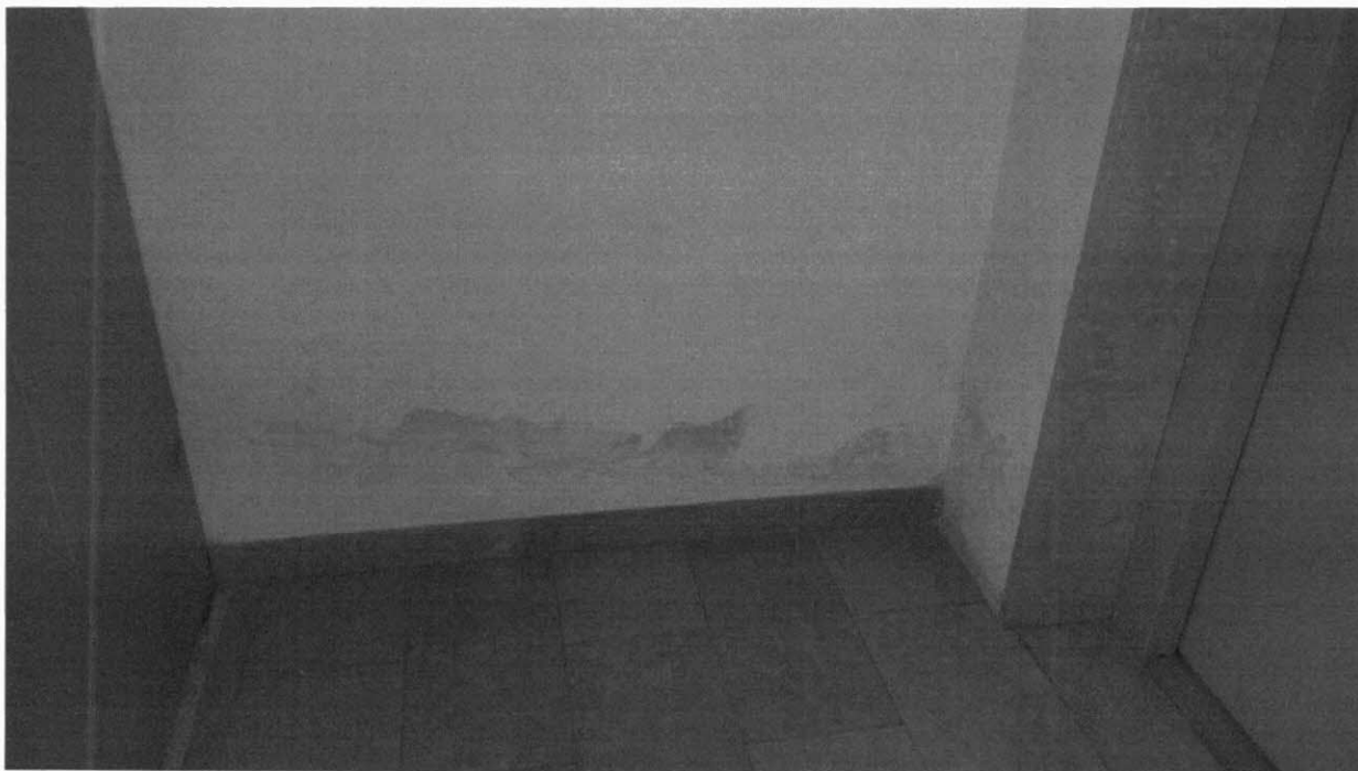
FOTO 14_Piano interrato_zona antistante ascensore
