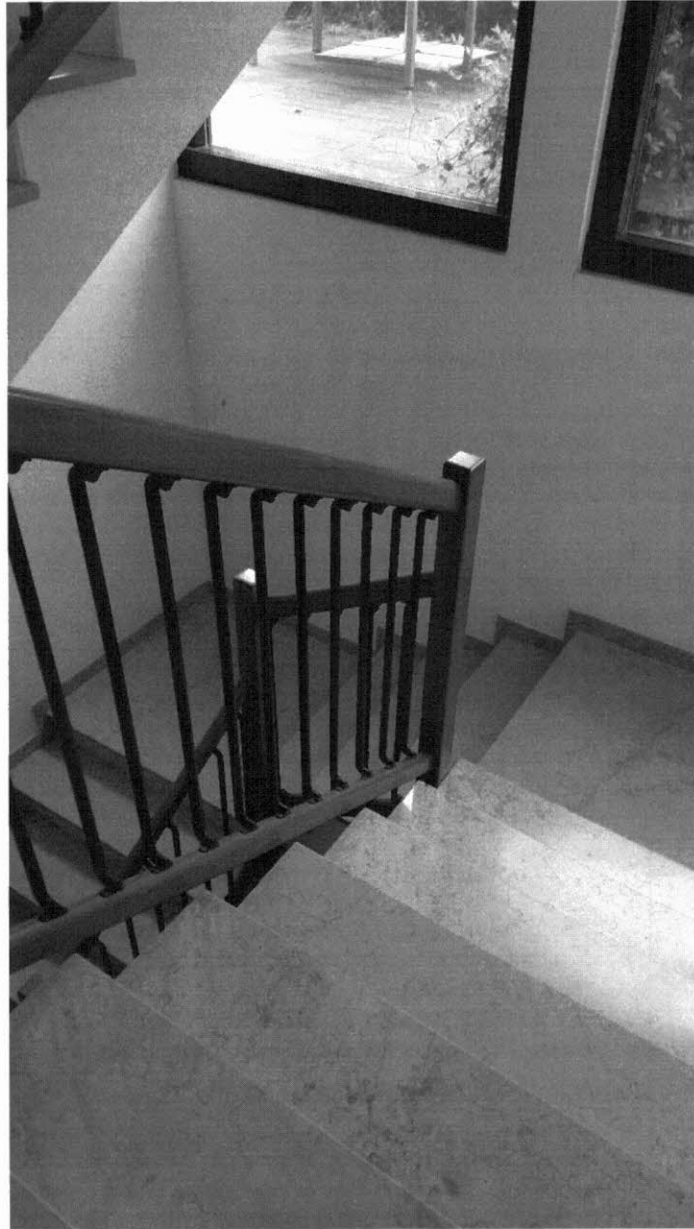
FOTO 13_Vano scala condomiale_Collegamento tra piano interrato e terra
