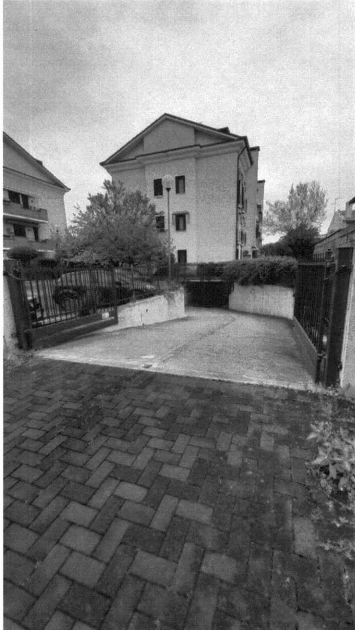
FOTO 9_ Accesso autorimessa_Rampa di collegamento piano terra con seminterrato
