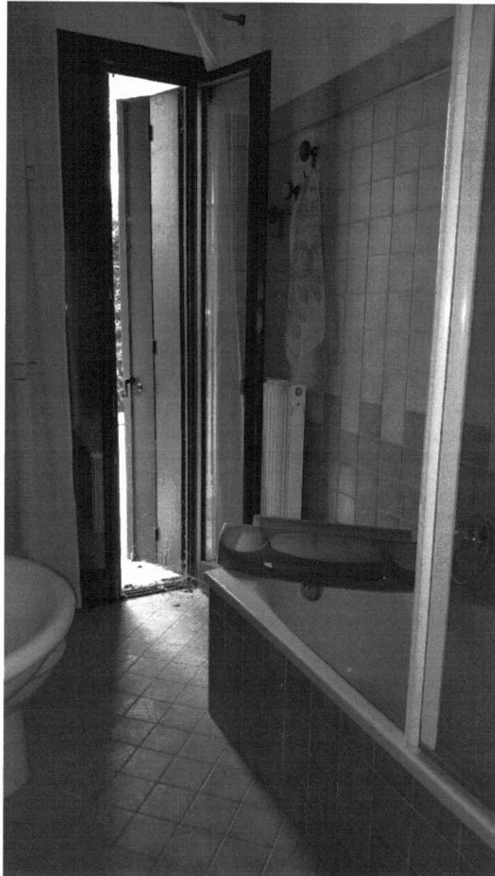
FOTO 29_Interno del locale bagno
