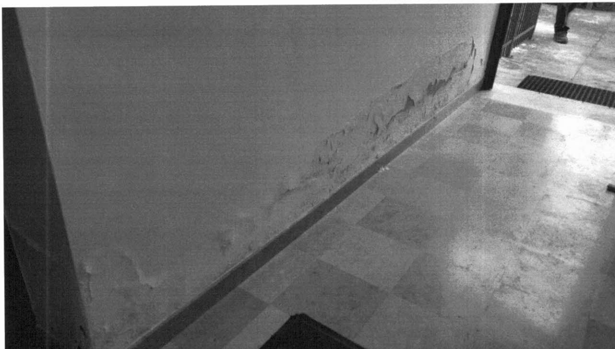
FOTO 25_Piano terra_Ingresso condominiale_Muro unità pignorata Sub 61
