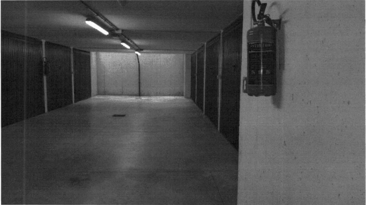
FOTO 19_Piano interrato_Spazio manovra antistante ai garage
