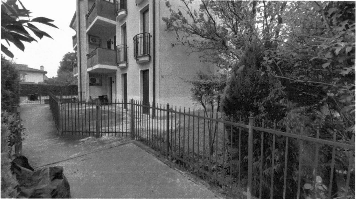
FOTO 5_Prospetto Nord-Ovest _Veduta appartamento pignorato comprensiva di giardino esclusivo e percorso pedonale condominiale
