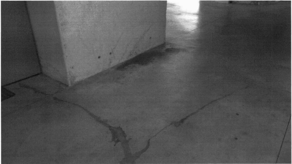
FOTO 21_Piano interrato_Particolare pavimentazione in corrispondenza porta REI di accesso al piano
