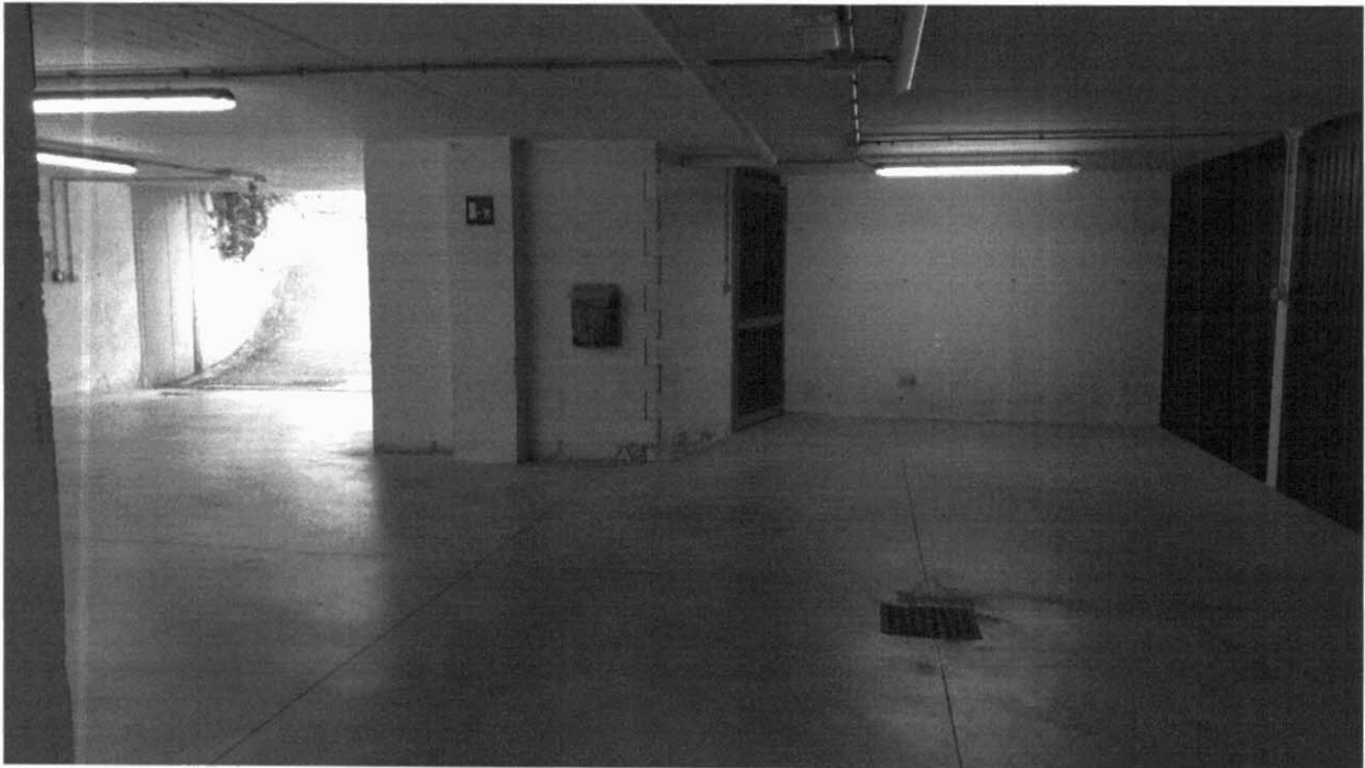
FOTO 20_Piano interrato_Spazio manovra antistante ai garage
