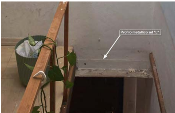
Figura 3: particolare dormiente ad "L"
