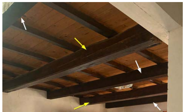
Figura 7: Travi del solaio sopra la cucina
