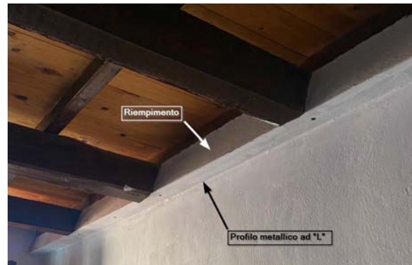
Figura 4: particolare appoggio travi
